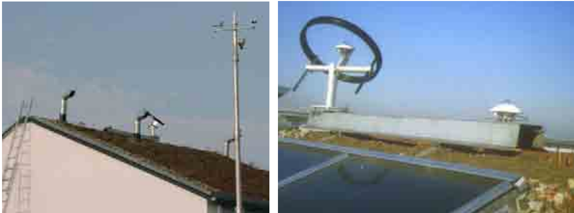
Abb. 6 und Abb. 7: Wetterstation in der Passivhaussiedlung. Links : Teleskopmast mit den Sensoren. Rechts : Strahlungsmessgeräte mit und ohne Schattenring auf dem First.
