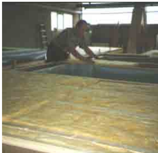
Abbildung 29: Der Dämmstoff muss locker und leicht überhöht im Element liegen, damit sich später keine Hohlräume bilden
