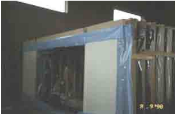
Abbildung 30 (links): Fensteröffnung des Fassadenelementes. Die Stöße der Luftdichtungsfolie sind sorgfältig verklebt, die überhängende Folie dient zur Herstellung der Luftdichtheit mit den anschließenden Elementen
