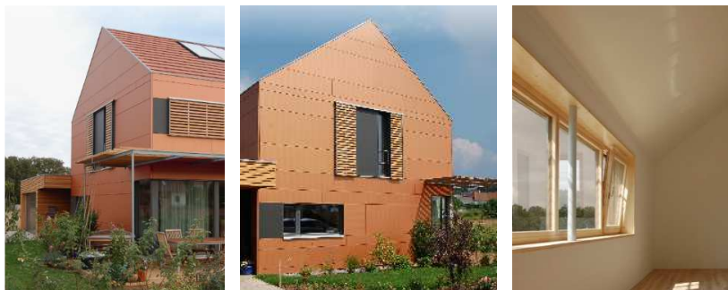
Abbildung 1: Referenzgebäude Architekten: Passivhaus-eco. Wohnfläche: 155 m 2 Heizwärme: 14 kWh/(m 2 a) PE-Kennwert: 61 kWh(m 2 a) n 50 : 0,2 1/h © Fotos: Passivhaus-eco
