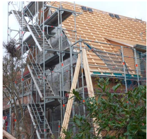
Die energetische Sanierung begann im Herbst 2023 (siehe Bild). Ein Dreivierteljahr später sind die Arbeiten an der Gebäudehülle so gut wie abgeschlossen. © Passivhaus Institut
