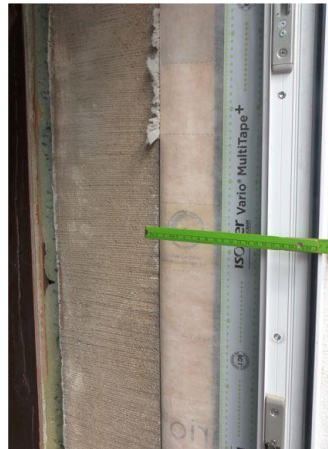
Bild oben: Beim Darmstädter Einfamilienhaus Baujahr 1928 ist der neue Wandaufbau mit der Dämmung um rund 30 Zentimeter dicker geworden. Fenster und Haustür sind entsprechend nach außen gerückt. Ein guter Wärmeschutz sorgt im Winter für angenehm warme Räume und schützt im Sommer vor Hitze. Zudem sinkt der Energiebedarf deutlich. Bild unten: Da die Höhe des Kellers für den Pufferspeicher mitsamt Rohren nicht ausreichte, hob die Baufamilie den Kellerboden an der betreffenden Stelle kurzerhand aus. © PHI
