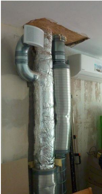
Die Lüftungsanlage mit Wärmerückgewinnung hat einen großen Anteil am deutlich verbesserten Raumklima. Die Rohre werden noch wohnlich verkleidet. © PHI
