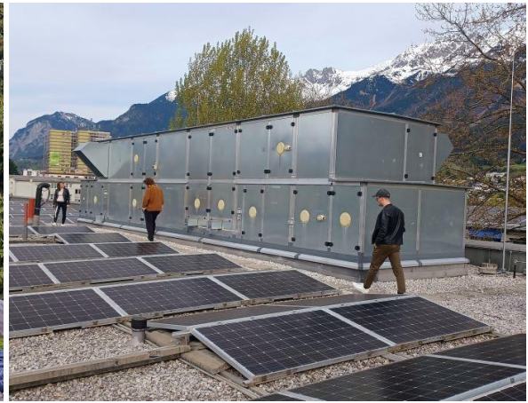
Die Volksschule Neuarzl in Innsbruck erreicht nach der Sanierung den EnerPHit-Standard. Die Vorteile: Ein stark reduzierter Heizwärmebedarf sowie ein deutlich erhöhter Komfort für alle nutzenden Personen sowohl im Winter als auch im Sommer. Auf dem Dach sind eine großflächige PV-Anlage sowie die Lüftungsanlage installiert. © Passivhaus Institut
