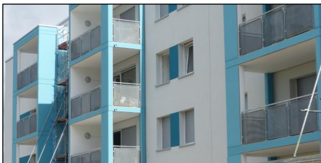
Energieeffizient und kostengünstig: Das Passivhaus-SozialPlus in Darmstadt ist ein bundesweites Modellprojekt des sozialen Wohnungsbaus. © Passivhaus Institut
