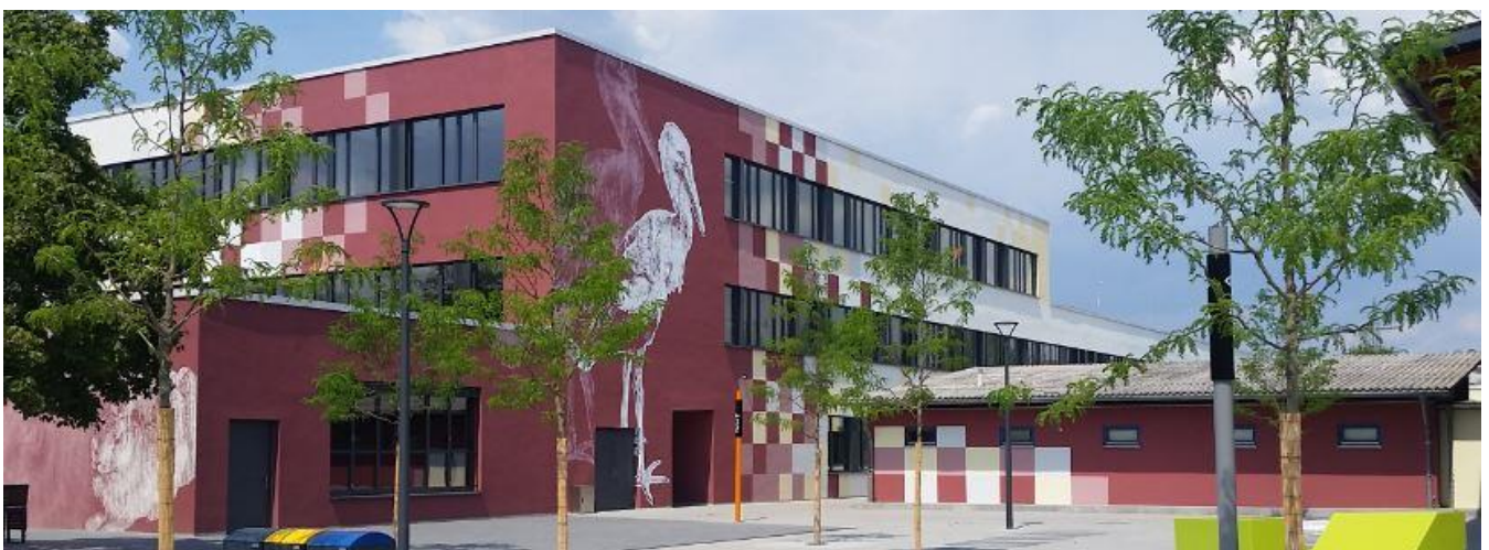
Die Albrecht-Dürer-Schule in Weiterstadt nach der Sanierung mit Passivhaus-Komponenten.
