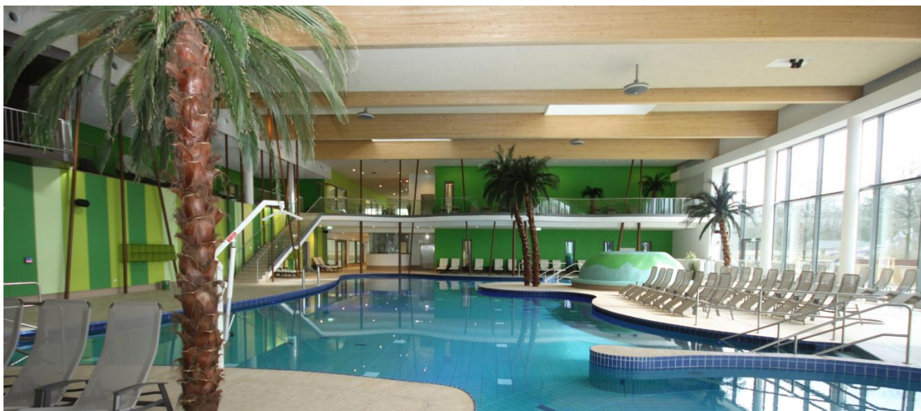
Das Passivhaus Institut beriet die Stadtwerke Bamberg beim Passivhaus-Schwimmbad "Bambados" und sorgte so für eine erfolgreiche Inbetriebnahme des Gebäudes sowie eine Betriebsoptimierung. Foto: Passivhaus Institut
