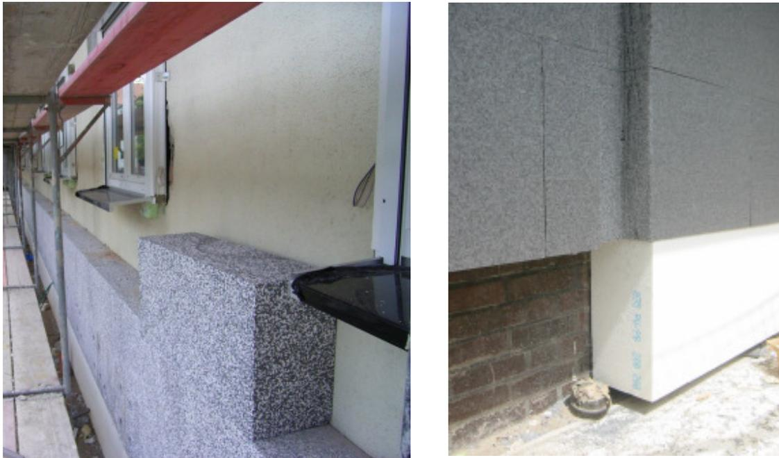
**Abbildung 9: Wärmebrückenreduktion am Perimeter. Links: realisierte Situation bei den Gebäuden Hoheloog und Schlesierstraße mit der Dämmung am Perimeter bis hinunter zur Gebäudesole. Rechts: Vereinfachte Ausführung am Gebäude Tevesstraße. Perimeterdämmung endet knapp über der Geländeoberkante [Kaufmann/Peper/Pfluger/Feist 2009]. Damit lassen sich die Kosten erheblich reduzieren.**
