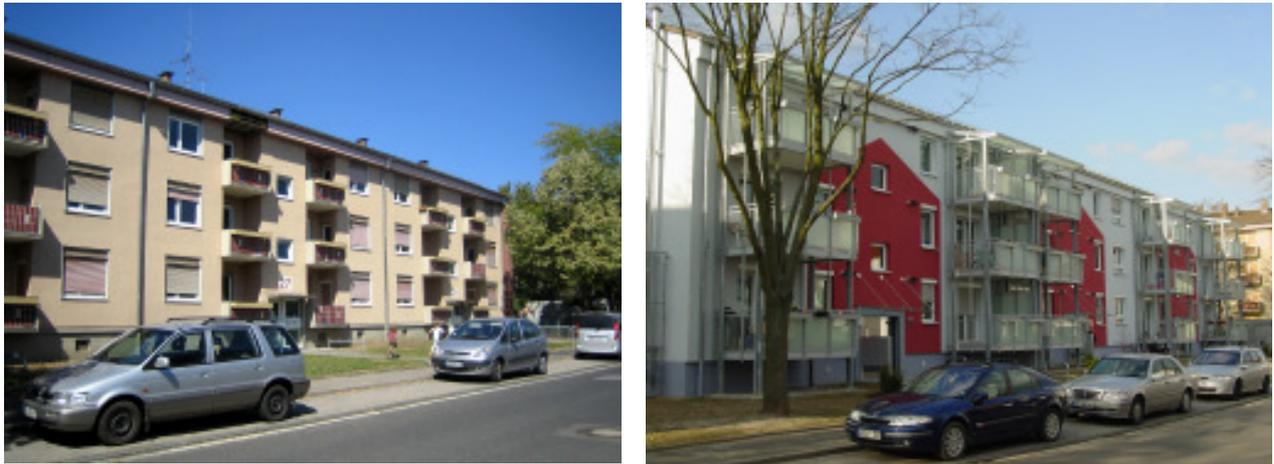
**Abbildung 4: Ursprünglicher Zustand der Gebäude Schlesierstraße 2005 (links) und die Gebäude nach der Sanierung 2008 (rechts).**
