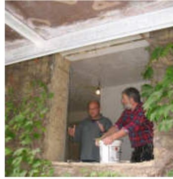
Vor dem Einbau der endgültigen Befestigung werden die Fensterlaibungen eingepasst und das Fenstermaß eingemessen. Auf den richtigen maßgenauen Abstand der Dämmelemente zur Innenwand und zur Fensterbrüstung ist zu achten.
