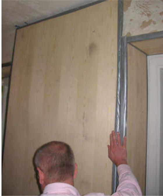
Nach Entfernen der Halte- Pressvorrichtung löst sich der obere Teil des Vakuum-Innenpaneels, der Klebvorgang muss nachgebessert werden.
