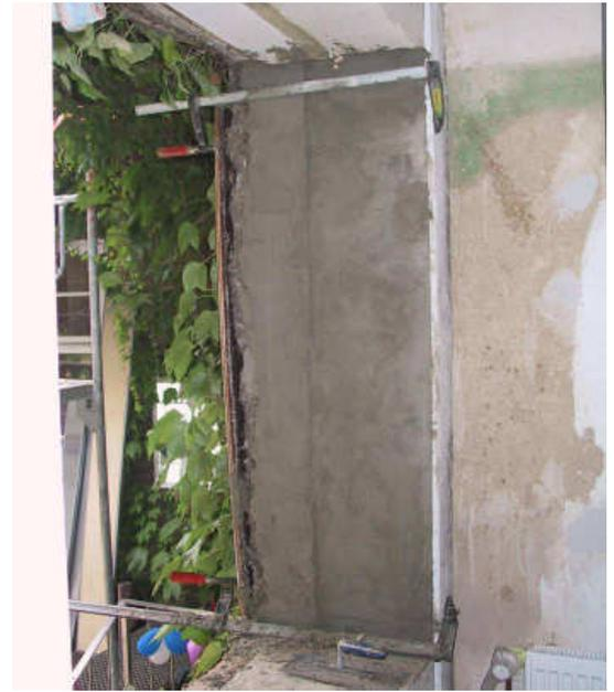
Da die Vakkumdämmplatten ausschließlich ohne mechanische Befestigung angebracht werden, ist es erforderlich eine *Kleberabreißprobe* durchzuführen.
