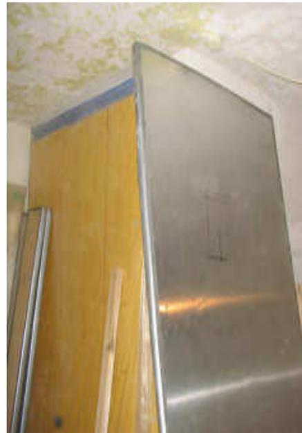
Die Flankenausbildung als Randabschluss der Platten wird durch einen Kantenschutz ausgeführt, ein umlaufendes Quellband ermöglicht zusammen mit einem Butylklebeband eine dichtschießende flexible Stoßfuge bei Pressverlegung der einzelnen QASA Sandwichplatten .
