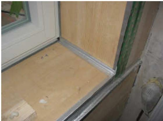
Die vorhandenen Maßtoleranzen von bis zu 1,5 cm sind insbesondere bei passgenau erforderlichen Bauteilen wie den Fensterlaibungen zu berücksichtigen
