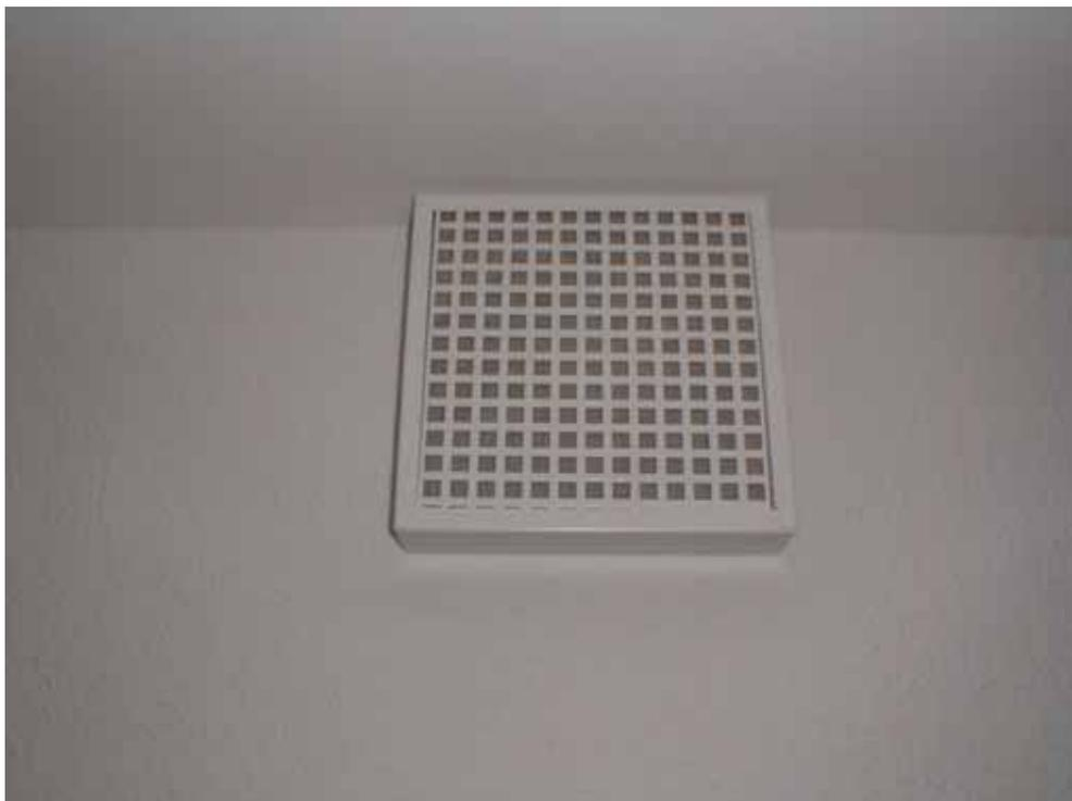
Abluftelement Küche mit vorgeschaltetem G3-Filterelement
