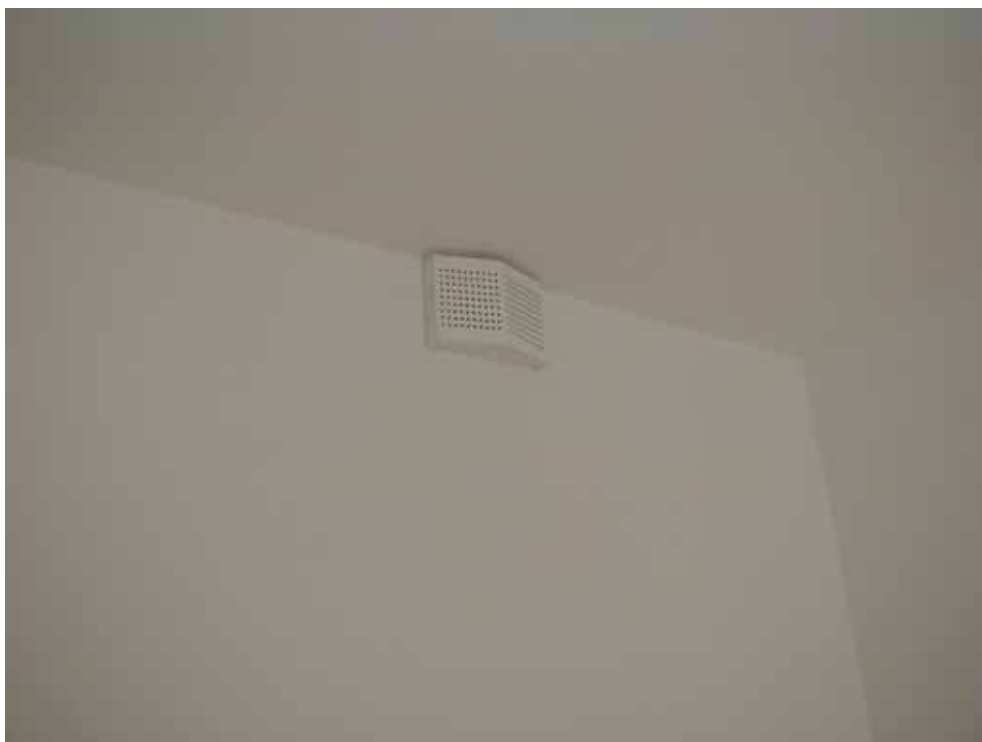
Zuluftelement (Weitwurfdüse) mit Lochgitterblech zur Einstellung
