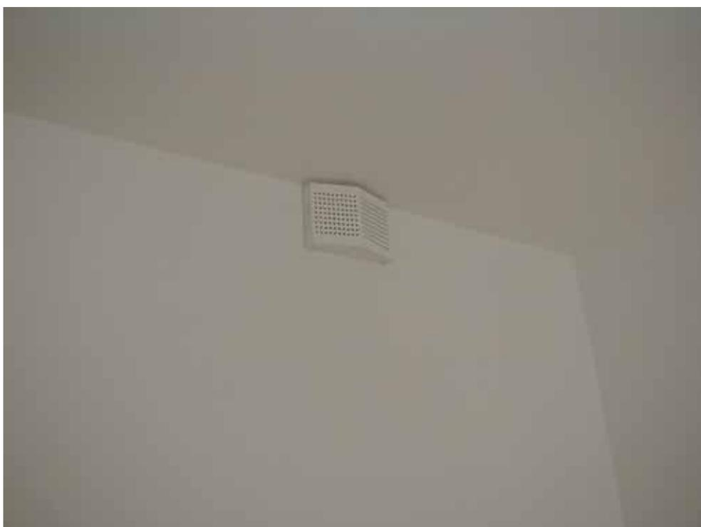
Zuluftelement (Weitwurfdüse) mit Lochgitterblech zur Einstellung
