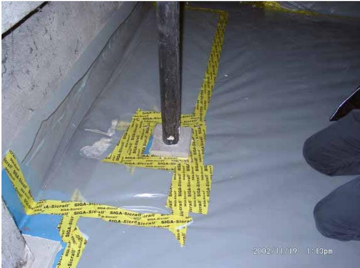
Abbildung 34: Durchdringung einer Fallrohrentlüftungsleitung durch die Decke.
