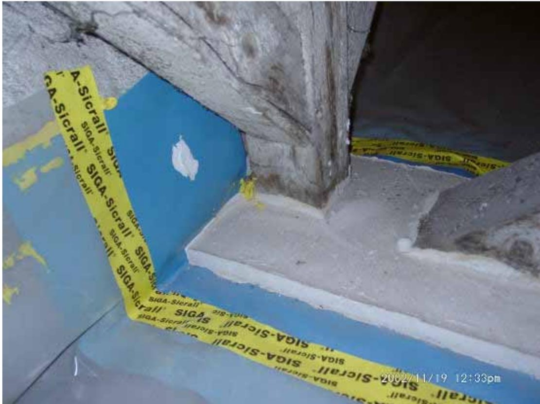
Abbildung 32: Detailaufnahme einer abgedichteten Balkendurchdringung.
