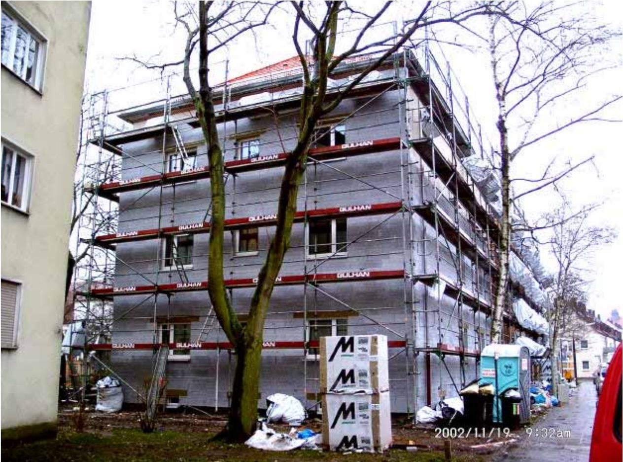
Abbildung 1: Ansicht der Ostfassade. Hier sind die Dämmplatten des WDVS bis auf eine kleine Stelle im Süden/oben bereits aufgebracht, aber noch nicht verputzt. Dagegen ist die Außenwand des Obergeschosses auf der Nordseite noch nicht gedämmt.
