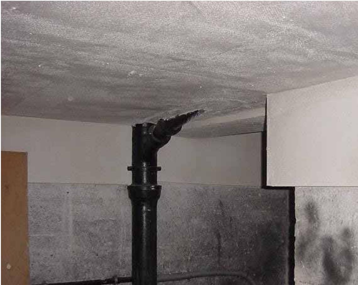
Abbildung 133: Kellerdeckendämmung mit durchtretendem Abwasserrohr.
