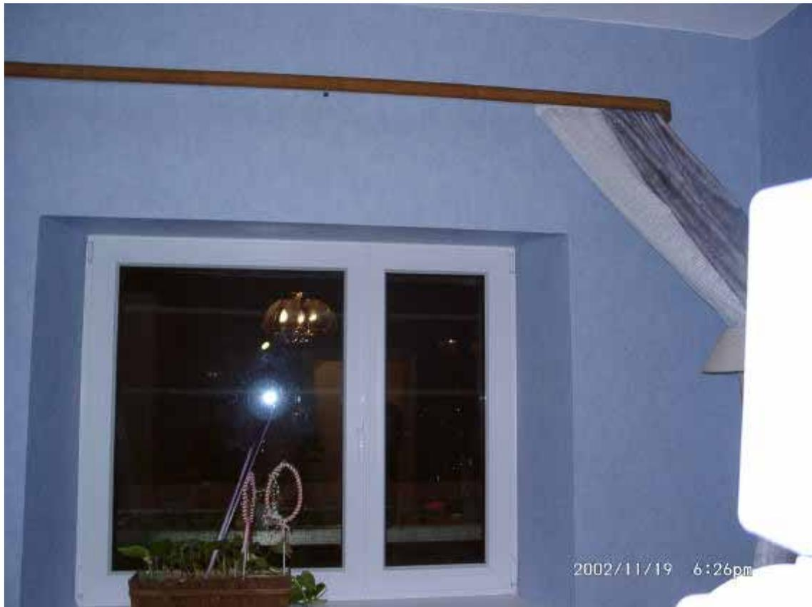
Abbildung 51: Innenaufnahme eines Fensters in der Südfassade. Der Einbau des Fensters ist abgeschlossen und die Außenwand ist in diesem Bereich bereits gedämmt.
