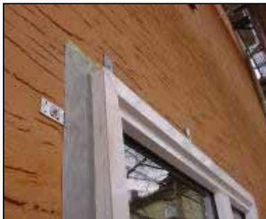
Abb. 7: Luftdichtung der Fenster außenwand-bündig
