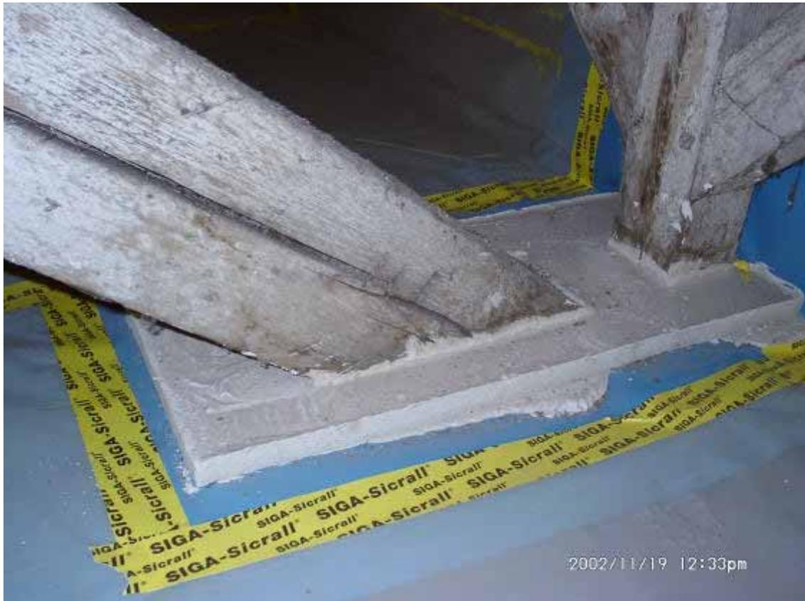
Abbildung 36: Detailaufnahme einer abgedichteten Balkendurchdringung.
