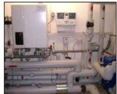
Abb. 26: Kunst am Bau: Dämmung der Leitungen im Heizraum
