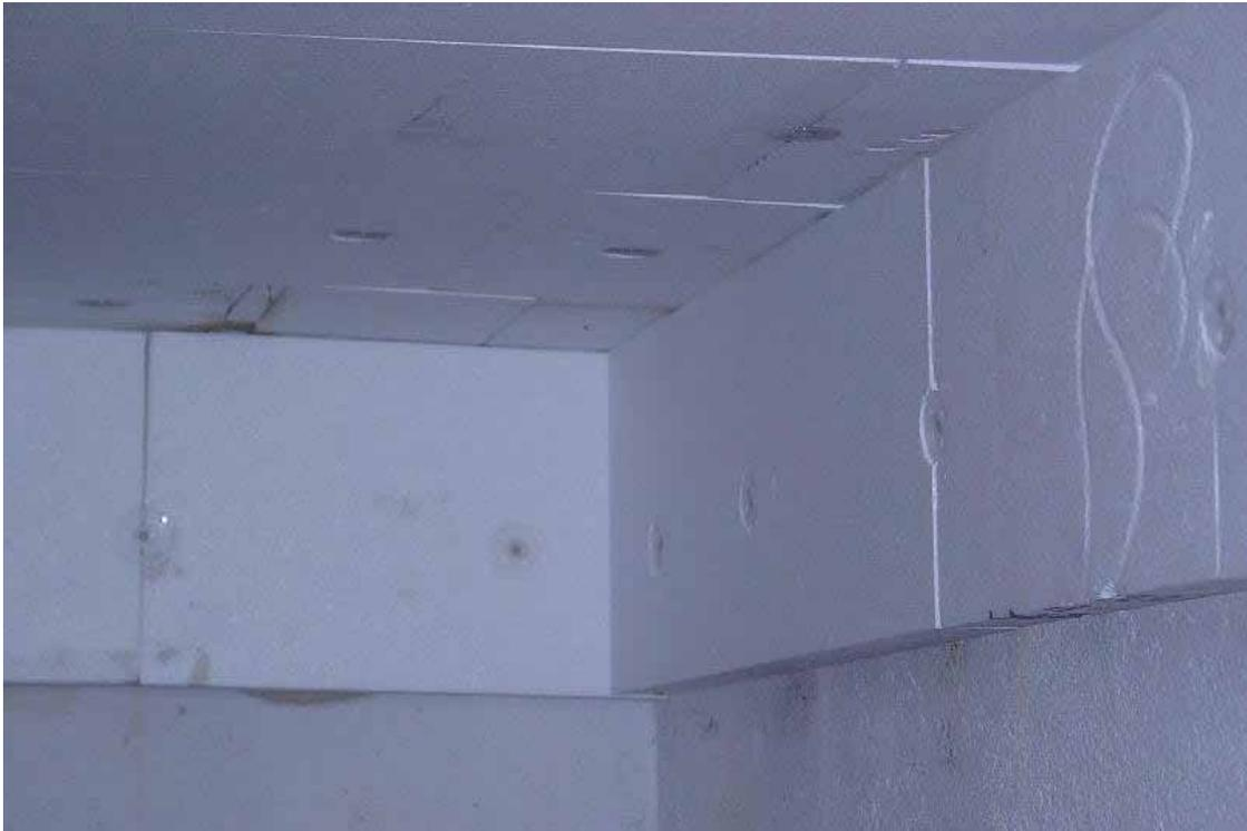
Abbildung 113: Dämmung der Kellerdecke mit Randdämmstreifen, noch ohne Spachtelung
