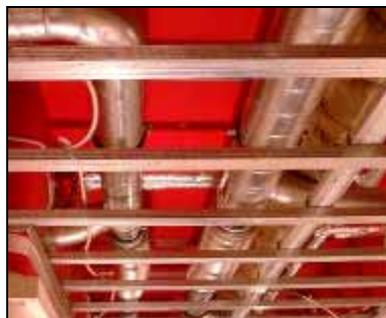
Abb. 25: Lüftungs- und Heizleitungen unter Flurdecke
