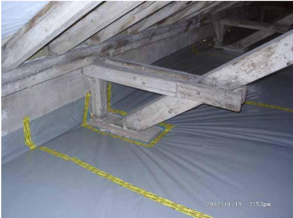
Abbildung 42: Detailaufnahme einer abgedichteten Balkendurchdringung.
