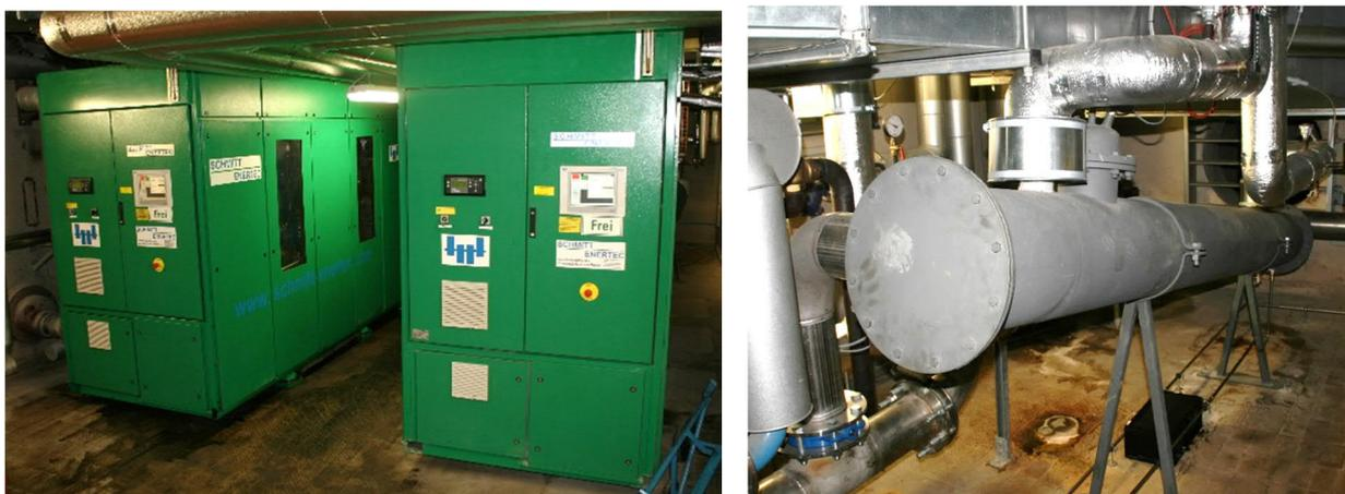
**Abb. 31:** Lippe-Bad Lünen: Erdgas und Biogas-BHKW (links) und Abgaswärmetauscher eines der BHKWs (rechts) macht "kostenlose" Abwärme nutzbar.
