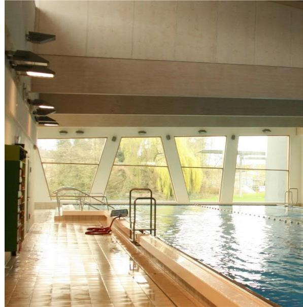
**Abb. 7:** Lippe-Bad, erhöhter Beckenkopf ermöglicht die Ausführung einer Brüstung für die PR-Fassade, ohne dass der Sichtbezug der Schwimmer nach außen beeinträchtigt wird.
