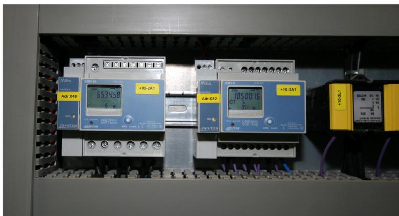
Abb. 32 Stromzähler in einem GLT-Schrank
