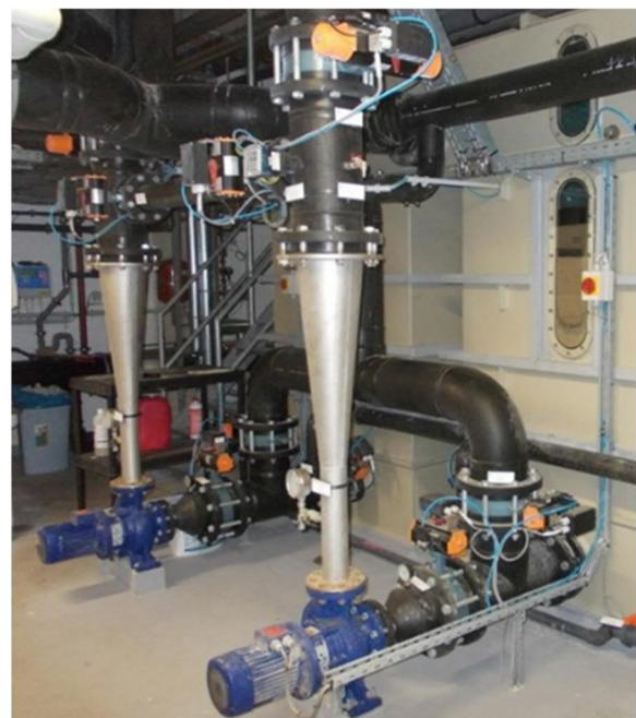
**Abb. 18: Umwälzpumpen im Beckenwasser-Kreislauf ohne (links) und mit (rechts) nachgeschaltetem Diffusor (Fotos: links PHI; rechts INCO)**
