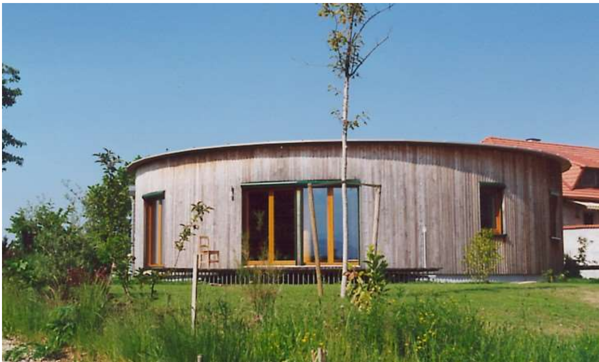
Abbildung 33: Außenansicht des Messobjektes Passivhausscheibe, im Salzkammergut in Österreich (Foto: Günter Lang).
