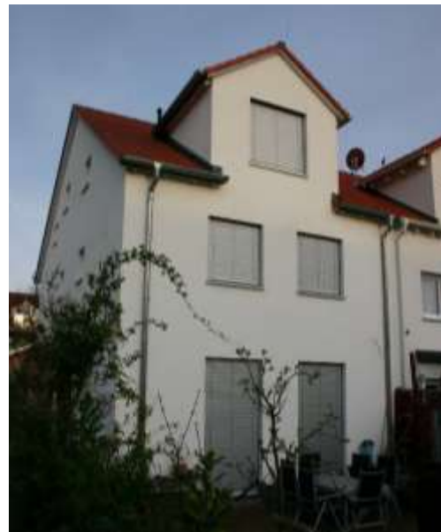
Abbildung 54: Östliche Vorder- (links) und westliche Rückansicht (rechts) des Reihenendhauses während der Messung. Die Jalousien an Ost- und Westseite sind geschlossen. Alle übrigen Fenster sind mit einer XPS-Platte abgedeckt.
