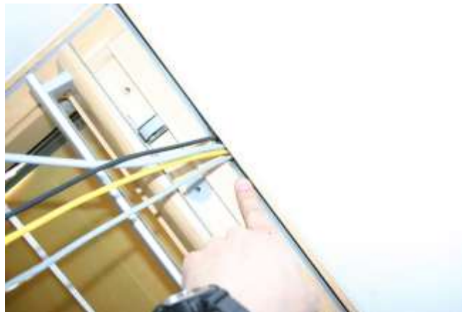
Abbildung 88: Durchführung der Kabel der Wetterstation durch das Dachflächenfenster.
