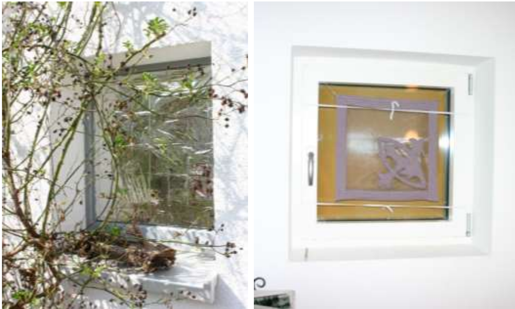
Abbildung 85: Außen- und Innenansicht des WC-Fensters, welches von außen mit einer XPS-Platte, die mit einer Rettungsdecke bedeckt wird, lichtdicht verschlossen wurde.
