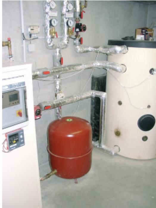
**Abbildung 61: Fernwärmeübergabestation (links), Pufferspeicher (rechts) sowie Ausdehnungsgefäß (mitte) in einem der beiden Technikhäuser der Passivhaussiedlung Hannover-Kronsberg vor dem Umbau im April 2002.**
