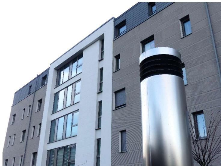
**Abbildung 5: Lüftungsturm vor dem Gebäude der zentralen Lüftungsanlage, welche sich im Keller des Gebäudes befindet.**
