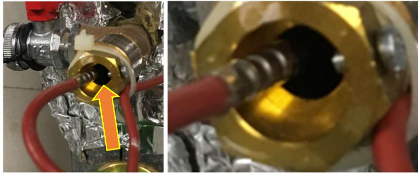
**Abbildung 6:** Temperatursensor eines Wärmehählers in der zu grohen Tauchhülse (Foto: Bewohner vom 09.04.2019). Der Pfeil zeigt auf den Hohlraum, welcher nicht ausgefüllt war. Die Vergrößerung ist im rechten Bild dargestellt.
