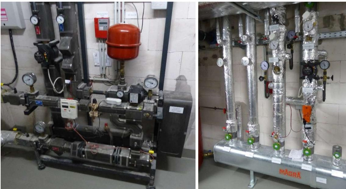
Abbildung 2: Technikeller mit der Übergabestation (links) und der zentralen Wärmeverteilung.
