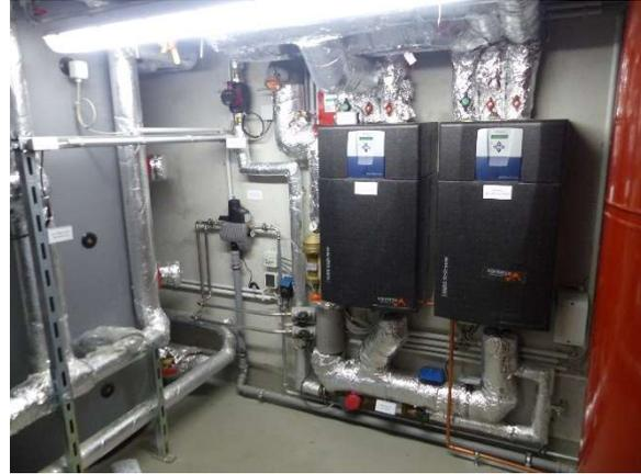
**Abbildung 3: Zentrale Lüftungsanlage im Technikeller (links) und zentrale Warmwasserbereitung mit zwei Frischwasser-Erwärmern (Wasser-Wasser-Durchlauferhitzer) (rechts).**
