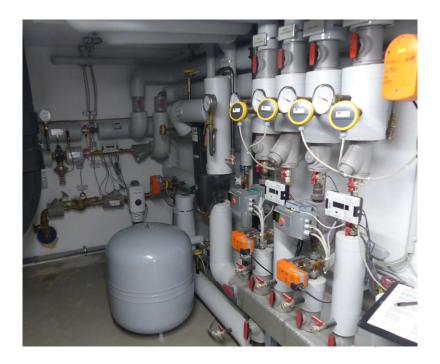
Abbildung 2: Technikkeller mit der Wärmeverteilung und Wärmezählern.
