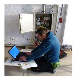
Abbildung 23: Zentraler Gesamtwärmezähler mit Ultraschall-Volumenstrommessung (ohne Auftrennung des Rohres) während der Montage am Fernwärmerohr im Keller des Gebäudes (links). Programmierarbeiten an der Messtechnikzentrale im Keller des Gebäudes (rechts).
