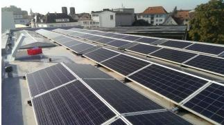
Abbildung 10: Montierte Wärmedämmung der Kellerdecke und Begleitdämmung an den Kellertrennwänden (links). PV-Anlage (29 kWp) auf dem neuen Flachdach (rechts).
