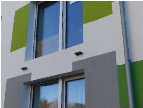
Abbildung 17: Anker für die neue, freistehende Balkonanlage vor und nach der Dämmung der Fassade. Diese Anker stellen eine massive Wärmebrücke dar, welche in der Bilanzierung berücksichtigt werden muss. Vorzuziehen wäre hier eine in der Substanz bessere thermische Entkopplung. (Vgl.: [Schulz 2007])
