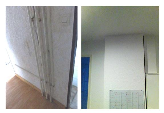
Abbildung 72: Steigleitungen der Fernwärmeversorgung vor (links) und nach der Sanierung (rechts)
