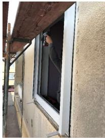
Abbildung 9: Montage der Außendämmung an der Fassade und Montage der neuen Fenster.
