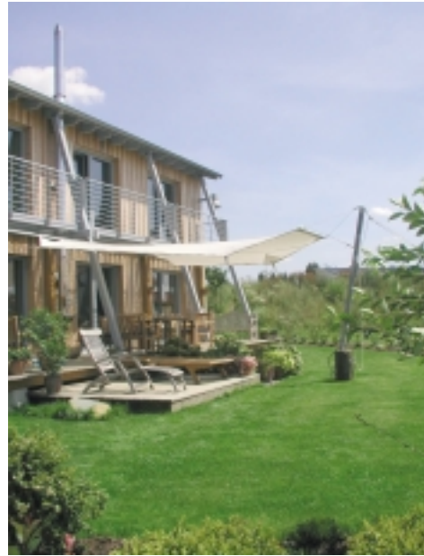
Abb. 17 Verschattung der Südfassade ohne Verdunklung durch den Dachüberstand und ein Sonnensegel. Haus der Familie Brandenburg in Rheda Wiedenbrück. Architekt: mensch&haus AG, Hamm. Foto: ILS NRW, Aachen
