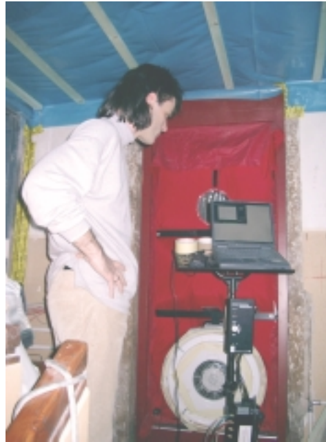
Abb. 91 Drucktest mit der Blower-Door. Foto: PHI
