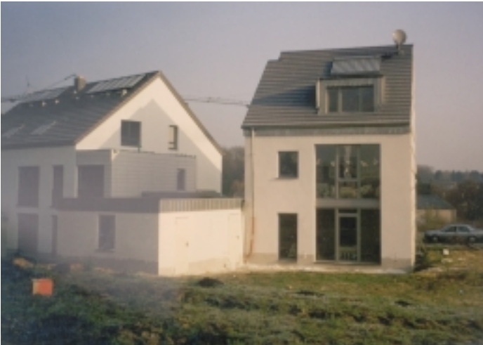
Abb. 6 Reihenhaus noch ohne Nachbarhaus. Man erkennt hier sehr deutlich das Missverhältnis von Oberfläche zu umbautem Volumen. Haus der Familie Maintz, Solarsiedlung Aachen. Architekt: Gerhard Weiss, Aachen; Foto: Institut für Landes- und Stadtentwicklungsforschung und Bauwesen (ILS NRW), Aachen
