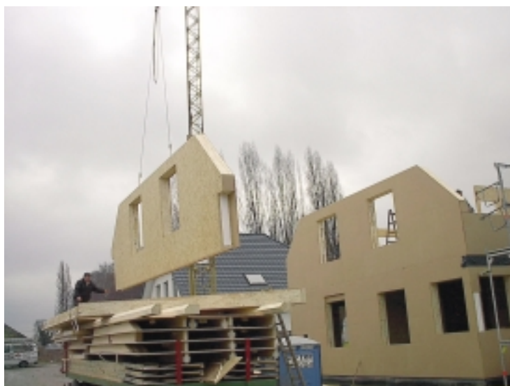
Abb. 32 Vorfertigung im Holzrahmenbau. Haus der Familie Höcker in Rheda-Wiedenbrück, Architekt: Mense Naturhaus, Beelen. Foto: Höcker
