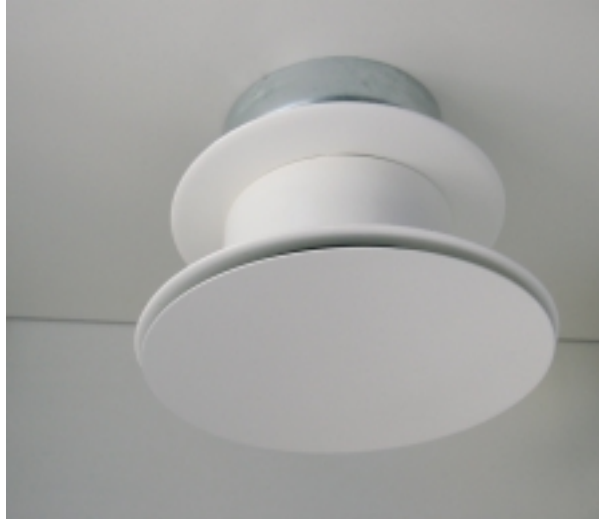
Abb. 77 Weitwurfdüsen (links) können z.B. an der Wand über der Tür angebracht werden, ohne dass Kurzschlussströmungen zwischen Zuluft und Überströmöffnung in der Tür auftreten. Es stehen auch Ventile für die Deckenmontage (rechts) zur Verfügung. Fotos: PHI
