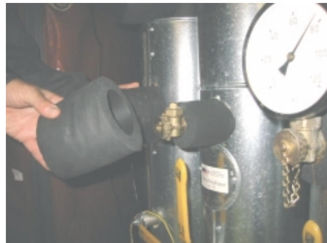
Abb. 105 Mit geeigneten Formstücken können die Armaturen gedämmt werden und bleiben trotzdem zugänglich. Foto: PHI
