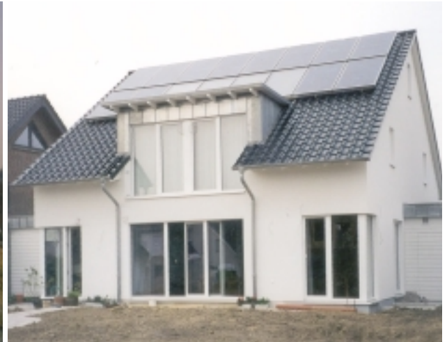
Abb. 7 Auch bei einer klassischen Bauform können großzügige Süd- fensterflächen realisiert werden. Hier wurde die Gaube im Obergeschoss für das Passivhaus optimiert. Haus der Familie Meyer-Gehlen in Mönchengladbach Odenkirchen, Architekt: M. Brausem, Köln; Foto: ILS NRW, Aachen
