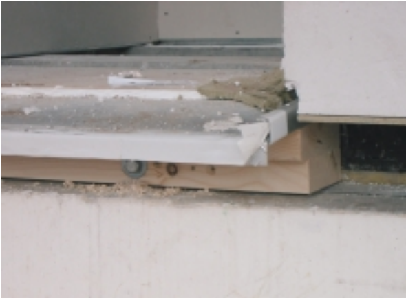
Abb. 85 Trittsichere Konsole unter einer Fenstertür. Wohnprojekt Wohnsinn, Darmstadt. Architekten: Faktor 10, Darmstadt. Foto: PHI
