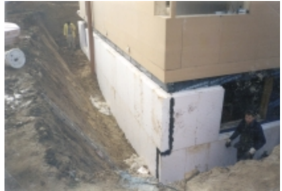
Abb. 12 Perimeterdämmung im Sockelbereich. Haus der Familie Meyer-Gehlen in Mönchengladbach-Odenkirchen, Architekt: M. Brausem, Köln. Foto: ILS NRW, Aachen
