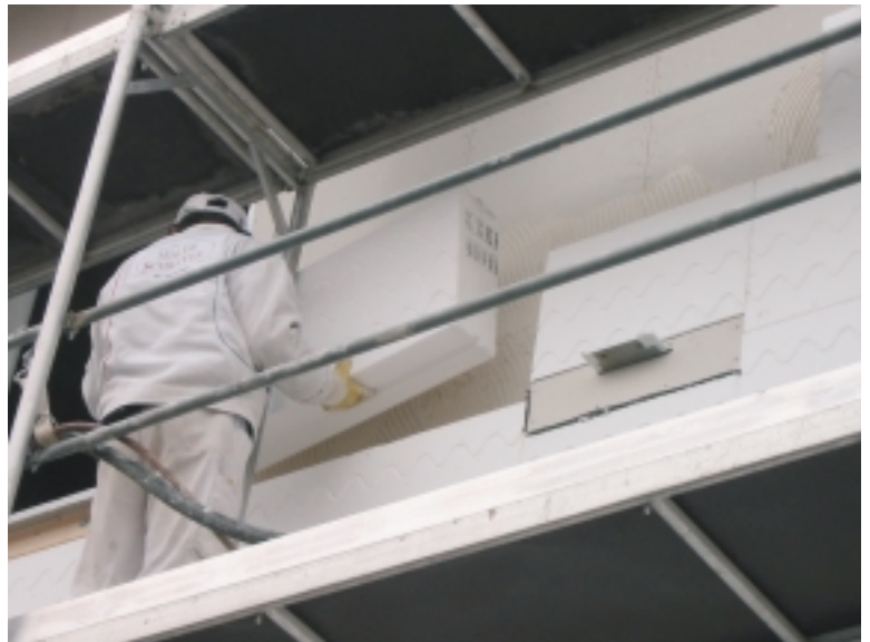
Abb. 83 Handelsübliche Wärmedämmverbundsysteme sind heutzutage auch in Dämmschichtstärken für das Passivhaus (bis zu 30 cm) erhältlich und können somit einlagig verarbeitet werden. Wichtig ist, dass die einzelnen Elemente sauber verklebt werden. Einige Anbieter fertigen formschlüssig ansetzbare Platten mit Nut und Feder (rechts). Fotos: ILS NRW, Aachen und PHI
