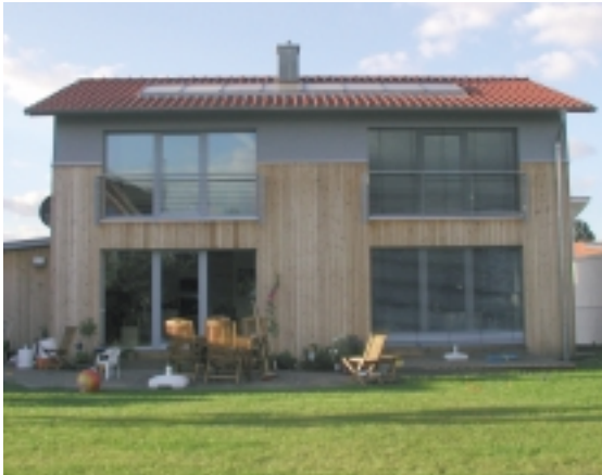
Abb. 16 Verschattung der Südfassade durch außenliegende Sonnenschutzlamellen. Haus der Familie Höcker, Rheda Wiedenbrück. Architekt: Mense Naturhaus, Beelen. Foto: ILS NRW, Aachen
