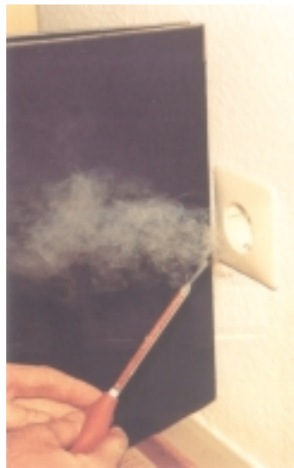
„Steckdosentaifun“ aus nicht luftdicht eingeputzter Unterputz-Steckdose, Foto: ebök, Tübingen
