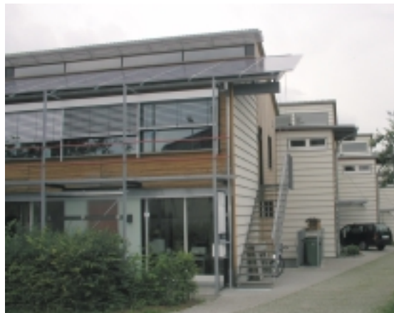
Abb. 15 Verschattung der Südfassade durch vorgestellte Stahlkonstruktion mit schmalen Balkonen. Haus der Familie Hinsenhofen, Detmold, Architekt: H.W. Hinsenhofen, Detmold. Foto: ILS NRW, Aachen
