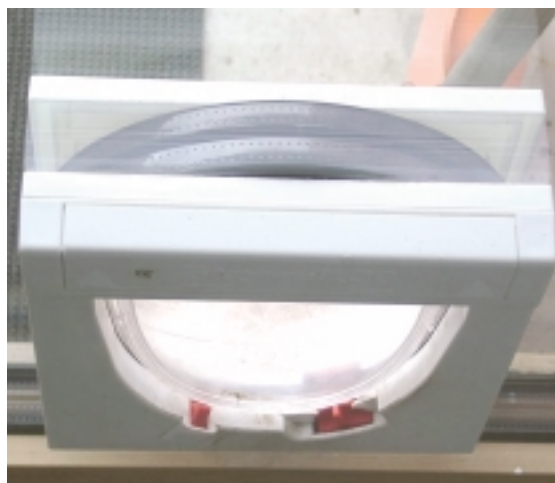
Abb. 72 Hochwertige Katzenklappe mit magnetischem Verschluss. Der Einsatz in eine Dreifach-Wärmeschutzverglasung wurde mit thermisch getrenntem Randverbund ausgeführt [76].
