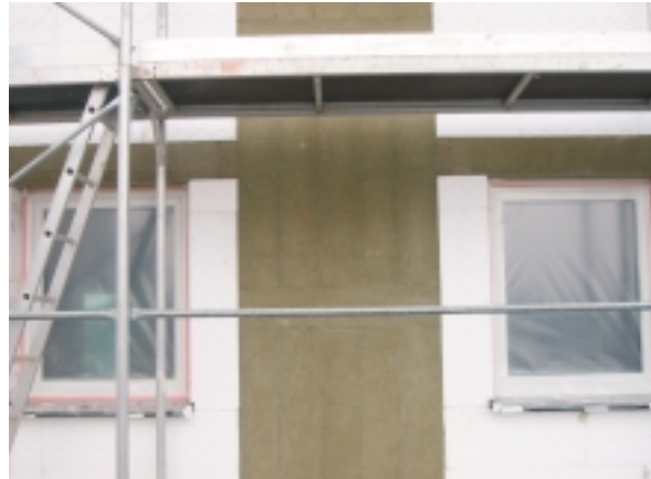
Abb. 86 Ein Wärmedämmverbundsystem aus Polystyrol muss an den Grenzen eines Brandabschnitts (Geschosswohnungsbau) und über dem Fenstersturz in Mineralwolle ausgeführt werden. Wohnprojekt Wohnsinn, Darmstadt. Architekten: Faktor 10, Darmstadt. Foto: PHI
