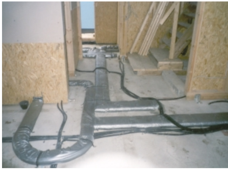
Abb. 76 Flachkanäle können platzsparend im Fußbodenaufbau oder in der abgehängten Decke untergebracht werden. Man beachte jedoch, dass das Kanalnetz nicht unnötig lang wird, damit sich die Druckverluste in Grenzen halten. Vgl. die Bemerkungen zu Abbildung 20 und Abbildung 21. Foto: ILS NRW, Aachen
