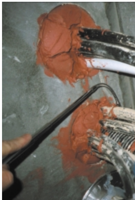
Gebündelte und abgeklebte Durchführungen. Foto: PHI
