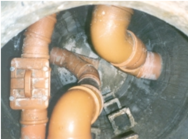
Abb. 102 Revisionsschacht des Erdkanals und Blick von oben in den Revisionsschacht. Fotos: ILS NRW, Aachen
