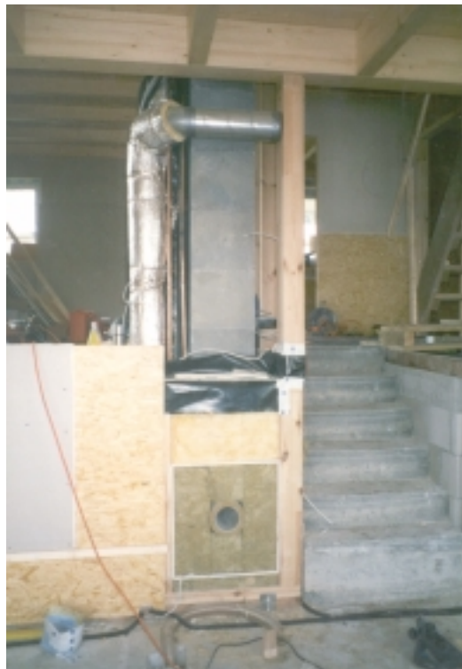
Abb. 23 Mit feuerfesten Materialien wärmegeprägter Kamin für einen Kaminofen im Wohnraum. Haus der Familie Dittrich, Solarsiedlung Beckum, Architektin: Johanna Tippkemper, Oelde. Foto: Dittrich, Beckum
