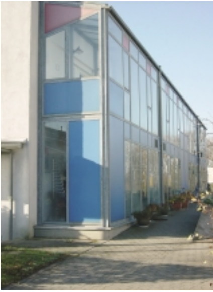
Abb. 10 Treppenhaus als nicht beheizter Vorbau außerhalb der thermischen Hülle. Der Zugang zum ebenfalls nicht beheizten Keller erfolgt über einfache Türen vom Treppenhaus her. Passivhaus in Darmstadt Kranichstein. Architekten: Bott, Ridder und Westermeyer, Stuttgart. Foto: PHI
