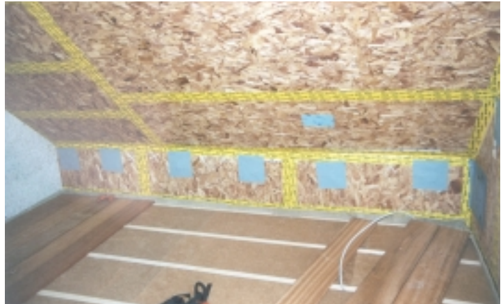
Abb. 54 Luftdichte Verklebung von OSB-Platten an den Stößen (gelb) und über den Bohrungen, die zum Füllen der Hohlräume gesetzt wurden (grau). Haus der Familie Trier in Köln. Architekt: Sabine Gabriel, Detmold. Foto: Familie Trier
