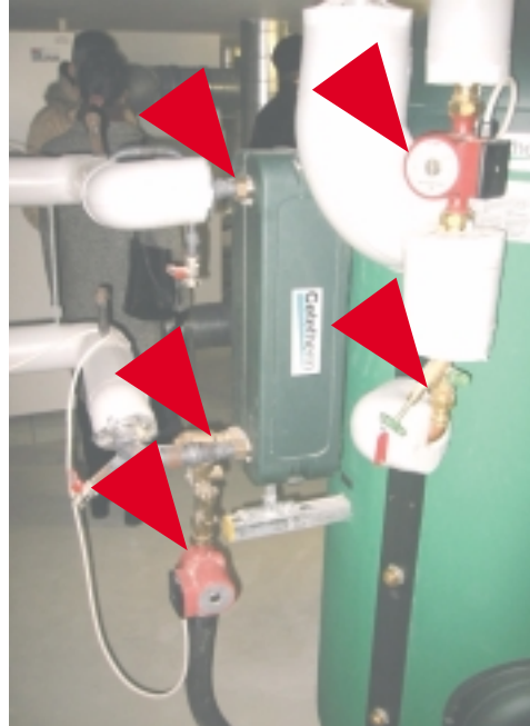
Abb. 80 Nicht gedämmte Speicheranschlüsse und Rohrleitungen verursachen unnötigerweise hohe Wärmeverluste. Fotos: PHI
