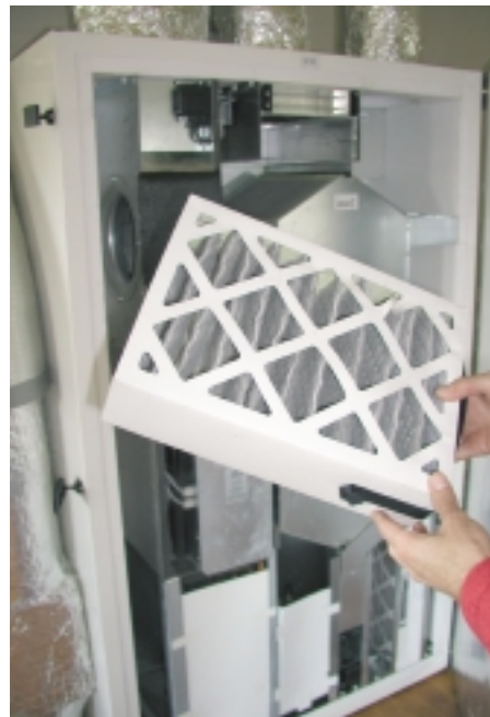
Abb. 74 Die Filter einer Lüftungsanlage müssen regelmäßig gewechselt werden. Foto: ILS NRW, Aachen
