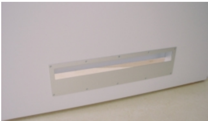
Abb. 79 Überströmöffnungen im Türsturz über der Tür oder im Türblatt integrierte Kanäle. Mit diesen Lösungen kann ein erhöhter Schallschutz erreicht werden. Ist dies nicht erforderlich, genügt eine einfache Öffnung im Türblatt, oder das Türblatt wird unten etwa 1 cm gekürzt. Der Druckverlust an Überströmöffnungen darf nicht über 1 Pa liegen. Grafiken und Foto: Hersteller bzw. PHI
