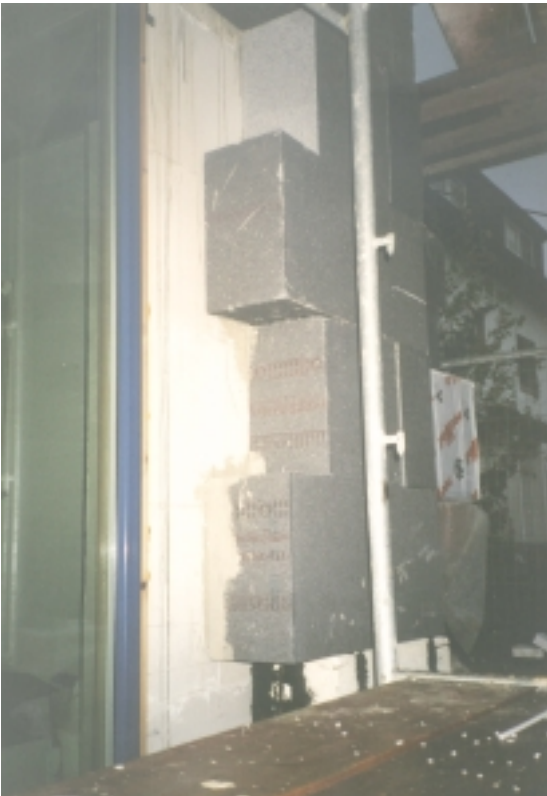
Abb. 83 Handelsübliche Wärmedämmverbundsysteme sind heutzutage auch in Dämmschichtstärken für das Passivhaus (bis zu 30 cm) erhältlich und können somit einlagig verarbeitet werden. Wichtig ist, dass die einzelnen Elemente sauber verklebt werden. Einige Anbieter fertigen formschlüssig ansetzbare Platten mit Nut und Feder (rechts). Fotos: ILS NRW, Aachen und PHI
