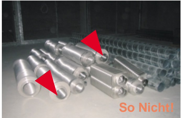
...sollten vor Schmutz geschützt werden. Dies gilt auch für schon eingebaute Anlagenteile, solange während der Bauzeit noch mit Staubentwicklung gerechnet werden muss. Fotos: PHI
