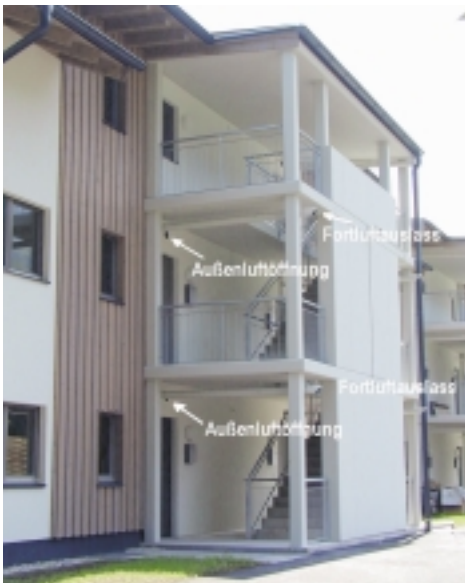
Abb. 75 Außenluftöffnung und Fortluftauslass im CEPHEUS-Projekt Kuchl, Österreich. Die Brandschutztechnischen Anforderungen, d.h. Abstand von Außenluftöffnungen zu benachbarten Fenstern etc. sind im Einzelfall mit den örtlichen Behörden abzustimmen. Foto: PHI
