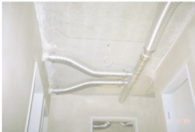
Abb. 22 Vorbildliches weil kompaktes Zu- und Abluftkanalnetz in einer Geschosswohnung. Ventilatoren, Kanäle und Telefonieschalldämpfer sind komplett in der abgehängten Decke von Bad und Flur verlegt. Die Zentraleinheit mit Wärmerückgewinnung für jeweils 8 Wohnungen befindet sich auf dem Dach des Hauses. Architekten: Hegger, Hegger, Schleiff, Kassel. Haustechnik-Planung: innovaTec Energiesysteme GmbH, Ahnatal-Weimar. Foto: PHI
