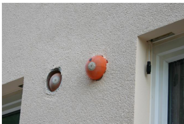
Sellado temporal de las aberturas de aire exterior y de expulsión del sistema de ventilación durante la medición.
