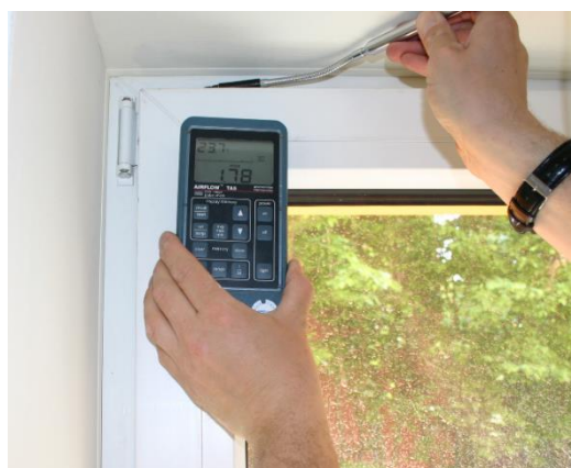
Medición con un anemómetro de la velocidad del aire en una ventana aún no ajustada correctamente durante el test de presurización.
