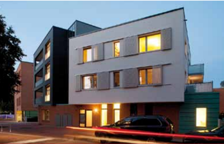
Titelbild: Torhaus Gilde-Carré, Hannover, Gerd Nord, Lindener Baukontor © Frank Auszieker
