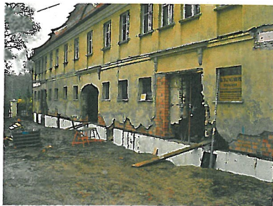
„Niedere Schloss“ Beginn Sanierung.
