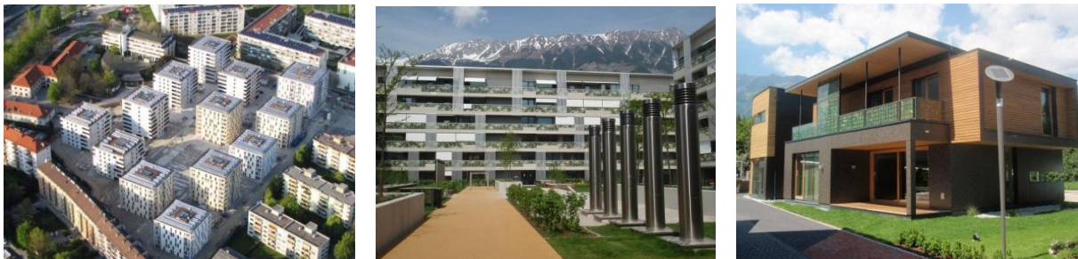
Bildleiste: Passivhäuser jeder Größenordnung bilden den Besichtigungsrahmen bei der 15. Internationalen Passivhaustagung in Innsbruck / Bild 1: O3 Olympisches Dorf mit 444 Wohnungen der Neuen Heimat Tirol, Reitter - Eck & Reiter Architekten ZT GmbH und din a4 / Bild 2: Wohnhausanlage Lodenareal mit 354 Wohnungen der Neuen Heimat Tirol, Architekten teamk2 und din a4 / Bild 3: Energiepark Innsbruck mit einer Auswahl von Passivhaus Eigenheimen für jeden Geschmack / Bildquellen: NHT und LANG consulting
