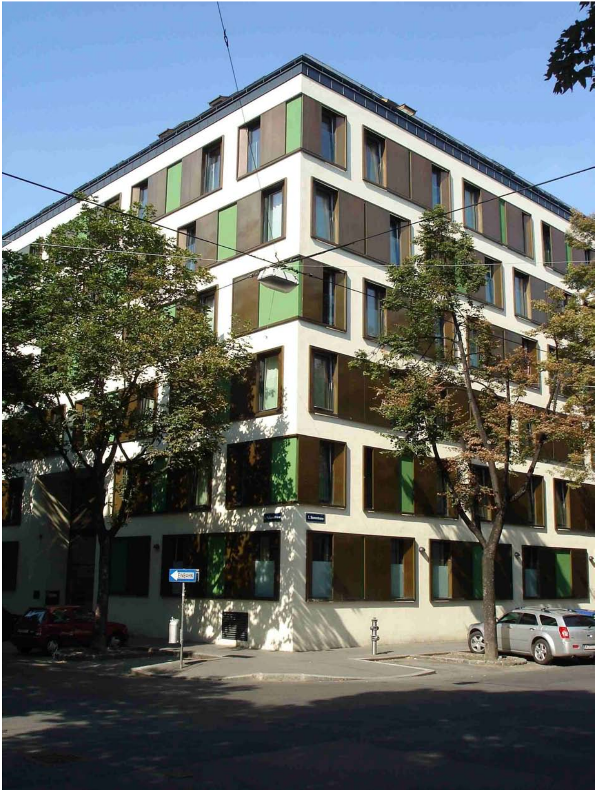
Studentenheim Molkereistraße Wien.jpg: In Passivhausstandard saniert wurde das Studentenheim in der Wiener Molkereistraße – Architektur: Baumschlager & Eberle. Copyright: Energieinstitut Vorarlberg/Helmut Krapmeier (Abdruck honorarfrei zur Berichterstattung über die 11. Internationale Passivhaustagung. Angabe des Bildnachweises ist Voraussetzung.)
