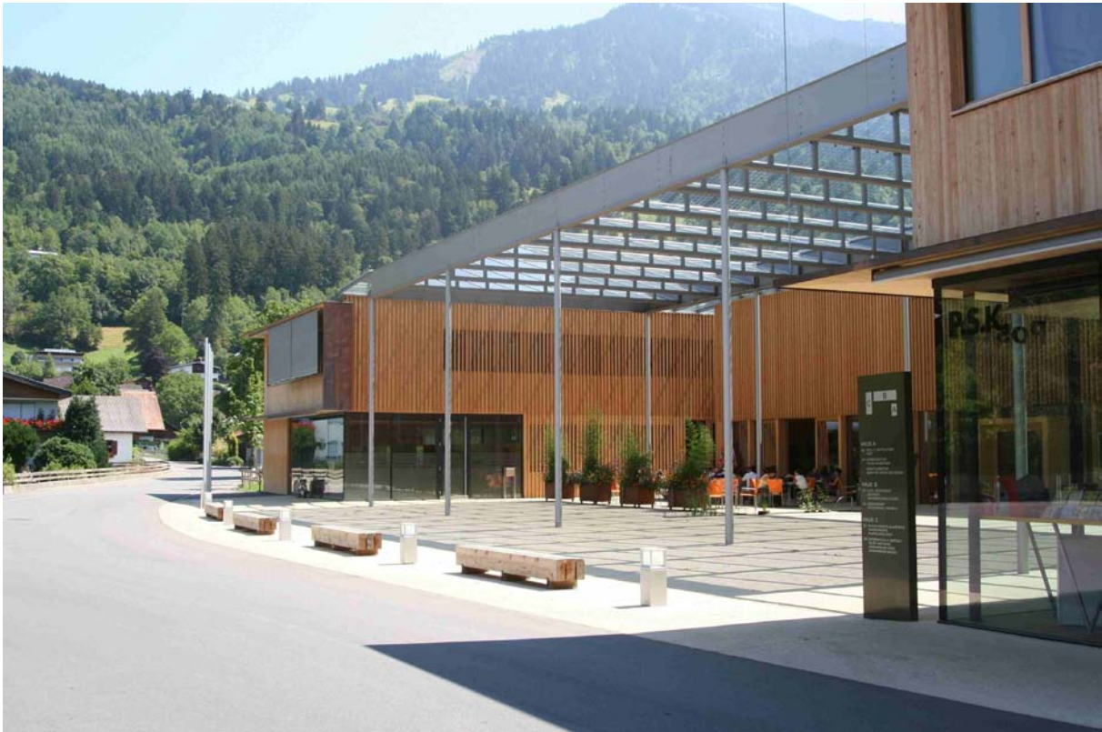
Gemeindeforum Ludesch.jpg: Passivhäuser finden sich zunehmend auch bei öffentlichen Gebäuden und Unternehmen. Im Bild das Gemeindeforum Ludesch in Vorarlberg (Österreich) – Architektur: Hermann Kaufmann. Copyright: Energieinstitut Vorarlberg/Dominique Gauzinmueller (Abdruck honorarfrei zur Berichterstattung über die 11. Internationale Passivhaustagung. Angabe des Bildnachweises ist Voraussetzung.)
