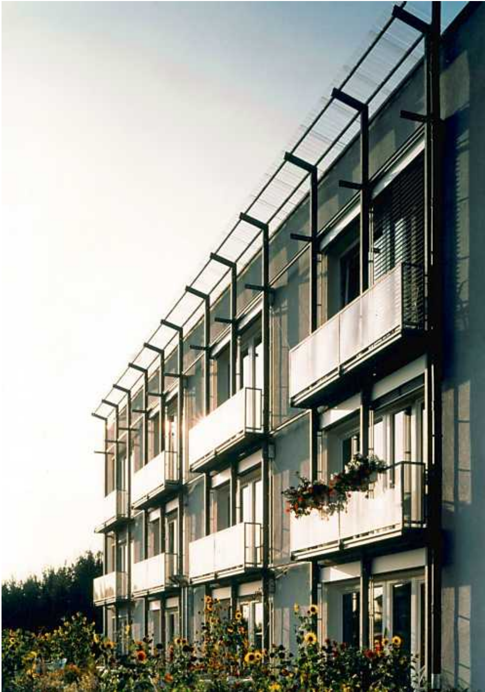
Passivhaus Darmstadt Kranichstein - Südansicht Architekten: Prof. Bott, Ridder, Westermeyer. Foto: H.G. Esch.
