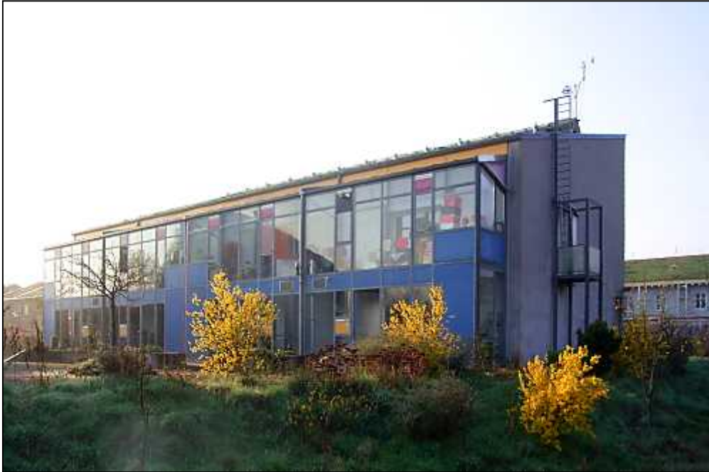
Nordansicht des Passivhauses Darmstadt-Kranichstein. Foto: Feist.
