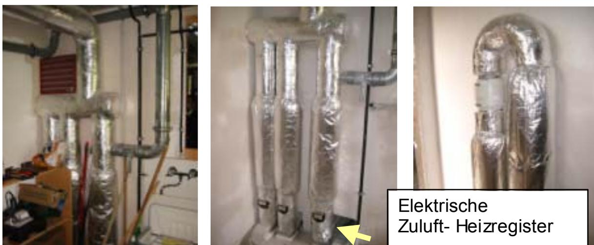
**Abbildung 37: Links: Bypassleitung für Sommerbetrieb. Mitte: PTC-geregelte elektrisch beheizte Zuluft- Heizregister, die der Wärmepumpe nachgeschaltet sind. Rechts: Umluftstrang für Heizbetrieb bei höheren Wärmeleistungen.**
