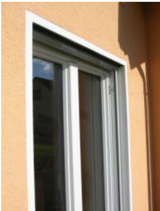
Abbildung 32: Wärmebrückenfreier Fenstereinbau,  $\Psi_{\text{Einbau}} = 0,02 \text{ W/(mK)}$ . Auch mit einem Kasten für die Aufnahme der Lamellenstores für die Verschattung ist der Wärmebrückenverlust akzeptabel. Insbesondere die Bauteiltemperaturen an den Innenoberflächen sind überall unkritisch.
