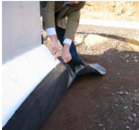
Abbildung 23: Fußpunkt der Außenwand. Anschluss an die Bodenplatte  $\Psi_a = -0,045 \text{ W/(mK)}$
