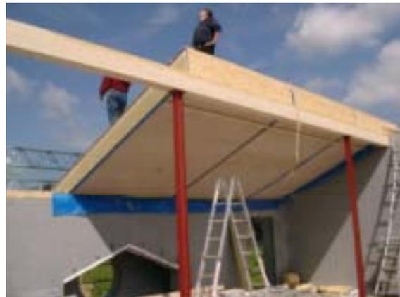
**Abbildung 11: Prinzipschema des Dachaufbaus mit tragendem Sparren (240 mm). Darüber liegt ein Kontersparren (160 mm) damit insgesamt eine Dämmstärke von 400 mm entsteht. Rechts: vorgefertigte Dachelemente werden auf First- und Fußpfette aufgelegt.**
