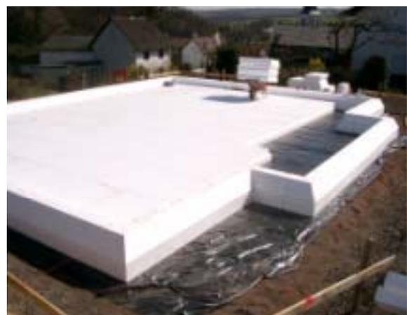
**Abbildung 12: Prinzipieller Aufbau der Bodenplatte und verschiedene Phasen bei der Erstellung.**
