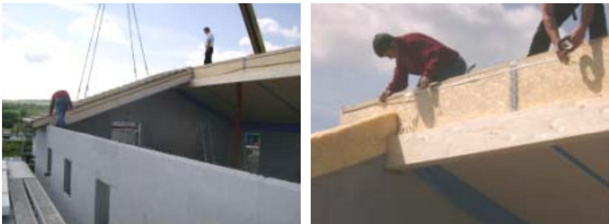
**Abbildung 28:** Herstellen des luftdichten Anschlusses der vorgefertigten Dachelemente durch Einlegen eines vorkomprimierten Schaumstoffbandes.
