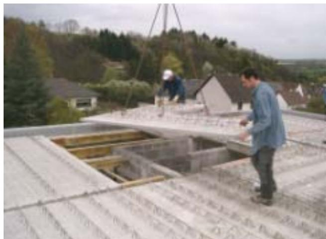
Abbildung 24: Anschluss Geschosdecke an Außenwand. Hier wird die Innenliegende Dämmschicht des Schalungselements durchbrochen,  $\Psi_a = +0,03 \text{ W/(mK)}$ , Tabelle 5.
