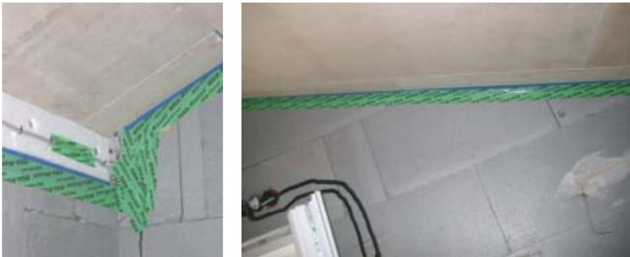
**Abbildung 15:** Die luftdichte Verbindung der unteren Beplankung des Daches mit den Außenwänden wurde mit Spezialklebeband hergestellt. Das Klebeband wurde später eingeputzt, wodurch die luftdichte Verbindung erst entsteht.
