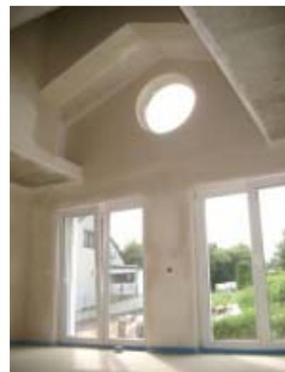
**Abbildung 14:** Verlauf der luftdichten Ebene (Innenputz) im vertikalen Schnitt und fertig verputzte Innenoberflächen der Außenwände.
