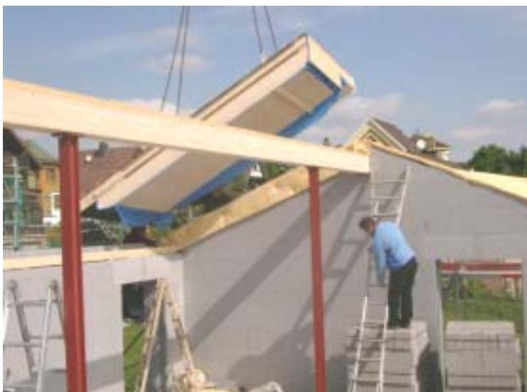
Abbildung 9: Sparrendach aus vorgefertigten gedämmten Dachelementen. Deutlich zu sehen sind die überstehenden Folienstreifen, die später mit den angrenzenden Bauteilen luftdicht verklebt bzw. eingeputzt werden.
