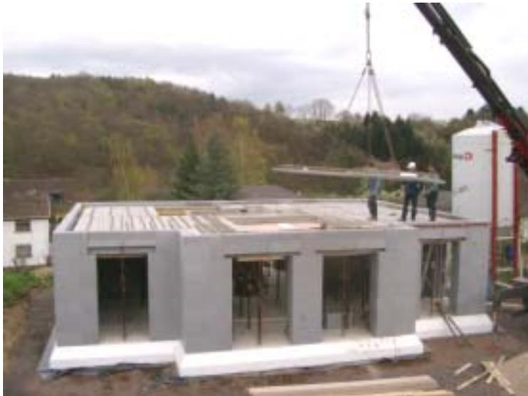
Abbildung 8: Herstellung der Zwischendecke als Filigrandecke.
