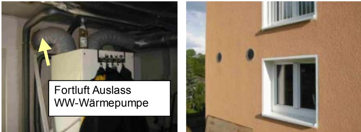
**Abbildung 36: Separates Wärmepumpenaggregat mit Pufferspeicher zur Warmwasserbereitung und Fortluftauslässe von beiden WP-Aggregaten auf der Nordseite des Gebäudes.**
