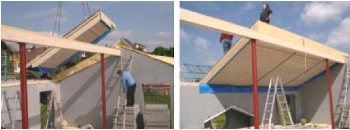
**Abbildung 27:** Anschluss First. Positionierung der Dachelemente auf First- und Fußpfette. Die luftdichte Folie (blau) ragt aus den Dachelementen hervor und kann später mit den Wänden verklebt und danach eingeputzt werden.
