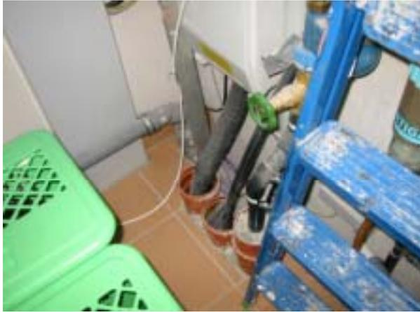
Abbildung 20: Durchführungen der Hausanschlussleitungen, Wasser, Abwasser, Elektrizität. Hier konnten keine messbaren Leckagen festgestellt werden.
