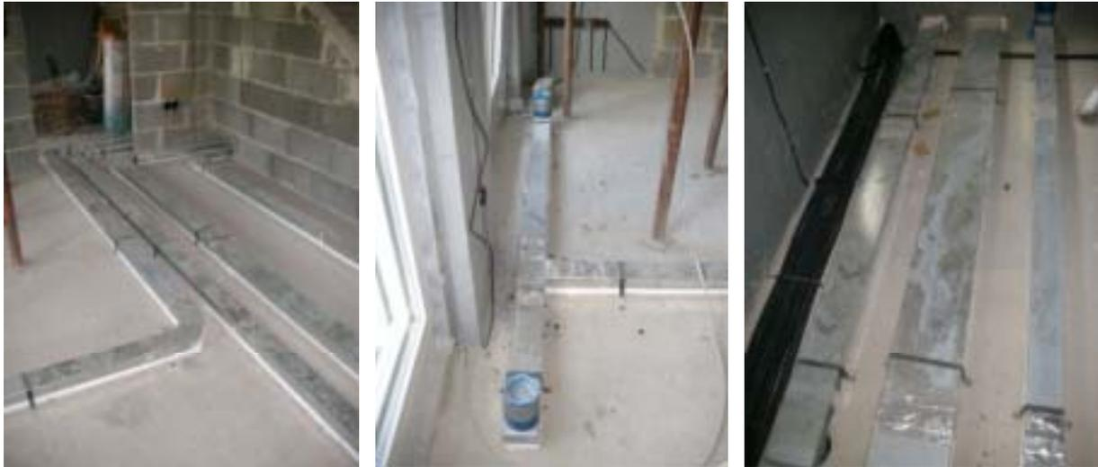
**Abbildung 38: Luftverteilung über Bodenkanäle bis zur den Fenstern.**
