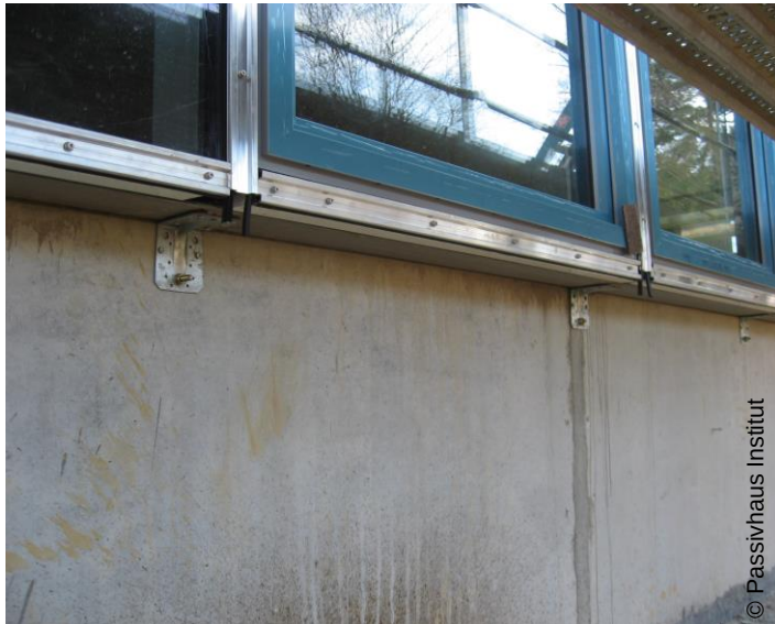
Abbildung 16: Einbau eines Fensterbandes vor der tragenden Wand in der Dämmebene.
