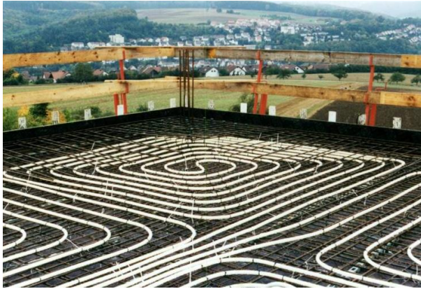
Abbildung 47: Rohrregister einer Betonkerntemperierung (Foto: Architekt Stefan Oehler). Energon, Ulm, Architektur Oehler Faigle archkom.
