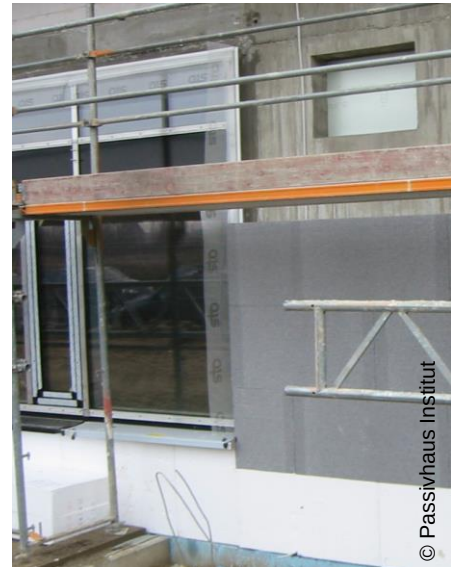
Abbildung 16: Einbau eines Fensterbandes vor der tragenden Wand in der Dämmebene.
