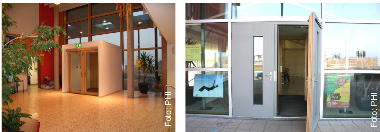
Abbildung 17: Eingangsbereich einer Passivhaus-Schule mit Windfang (Frankfurt Riedberg). Architektur: 4a, Stuttgart [Kah et al. 2010].
