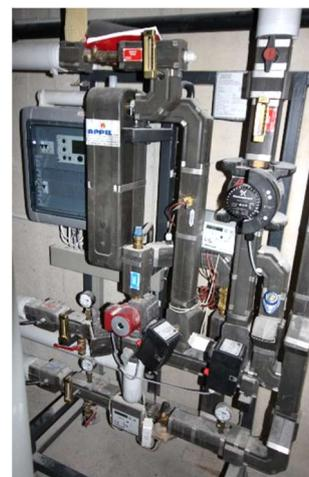
**Abbildung 3: Fernwärmeübergabestationen in zwei der untersuchten Gebäude (Fotos: PHI)**
