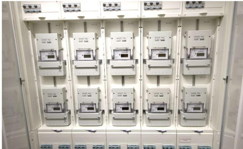
Abbildung 20: Beispiel für 10 der ca. 1.200 Smart Meter Stromzähler in einem der untersuchten Gebäude (Technikkeller).
