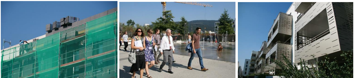
Heidelberger Bahnstadt: Dämmarbeiten, Spaziergang durch den neuen Stadtteil und Hingucker-Balkone
