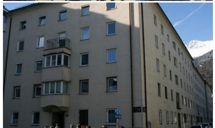
Dieses Mehrfamilienhaus in Innsbruck erhielt im Rahmen von SINFONIA neben einem guten Wärmeschutz auch eine Aufstockung (Ansicht unten vor der Sanierung). © Passivhaus Institut
