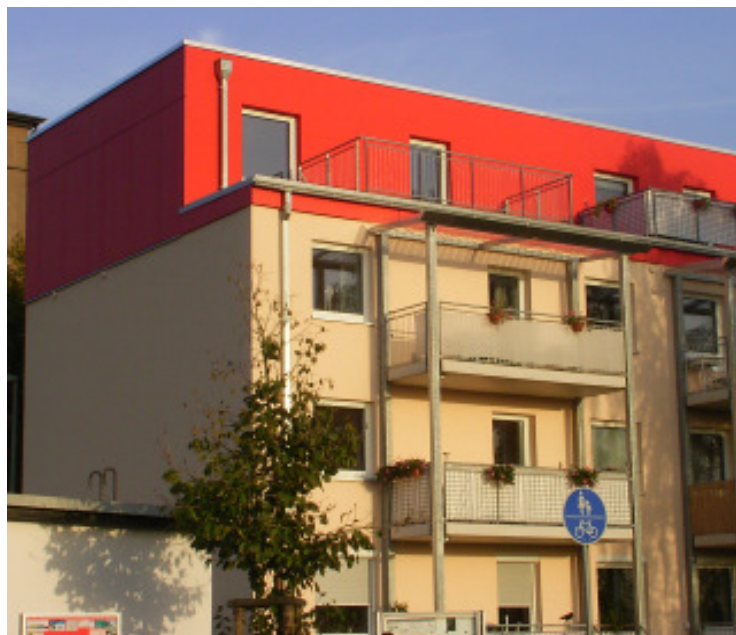
Abbildung 6: Detail der Westfassade des sanierten 4er Blocks.
