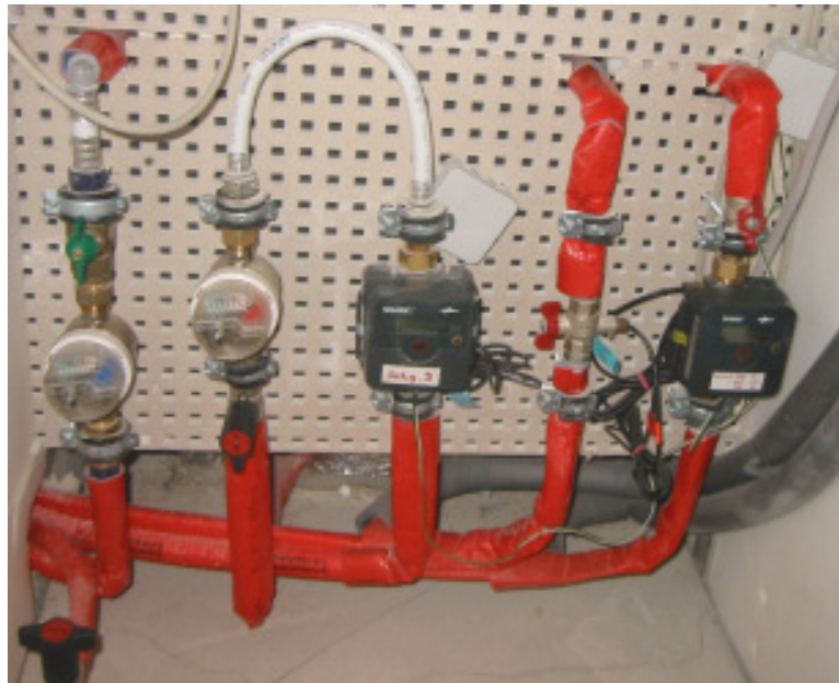
Abbildung 13: Installierte Wärmemengen- (schwarz) und Wasserzähler (rund) in einer der 19 Wohnungen im 4er Block. In der Installationsdose hinter dem WMZ in der Bildmitte befindet sich der gewickelte Konstantanwiderstand für die Warmwassermessung.
