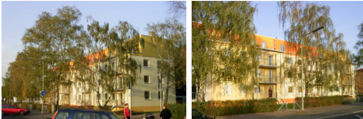
Abbildung 31: Süd-West- und Westfassade der Gebäude Tevesstraße 48 bis 54.
