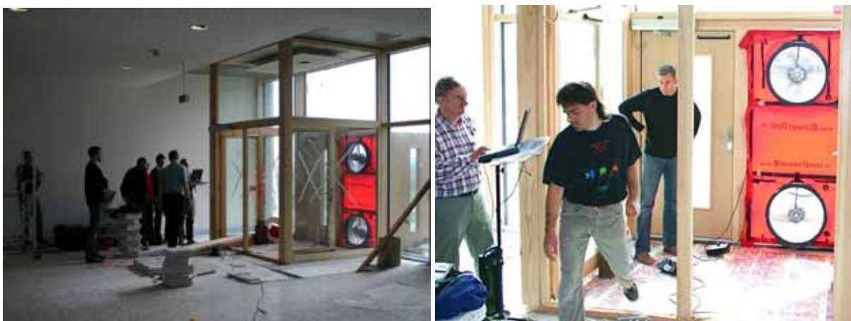
Abbildung 27: Blower Door Messung mit zwei Gebläsen.
