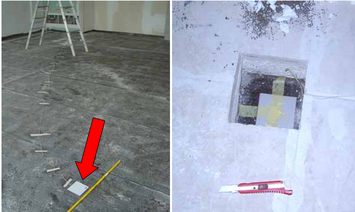
Abbildung 42: Montage der Wärmestrommessplatten in Raum 0.3 (vor dem Einbringen der Dämmung) und im Bodenaufbau im Flur vor Raum 0.3.
