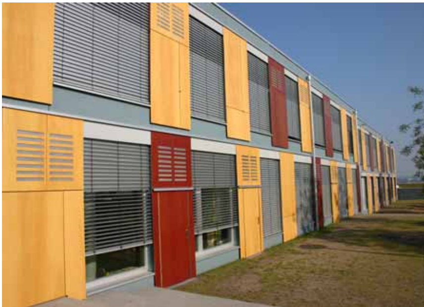
Abbildung 26: Südfassade des Nordflügels mit heruntergelassener Außenverschattung.
