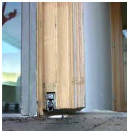
Abbildung 149: Untersuchte Außentür mit Türdichtung und Anschlagdichtung.
