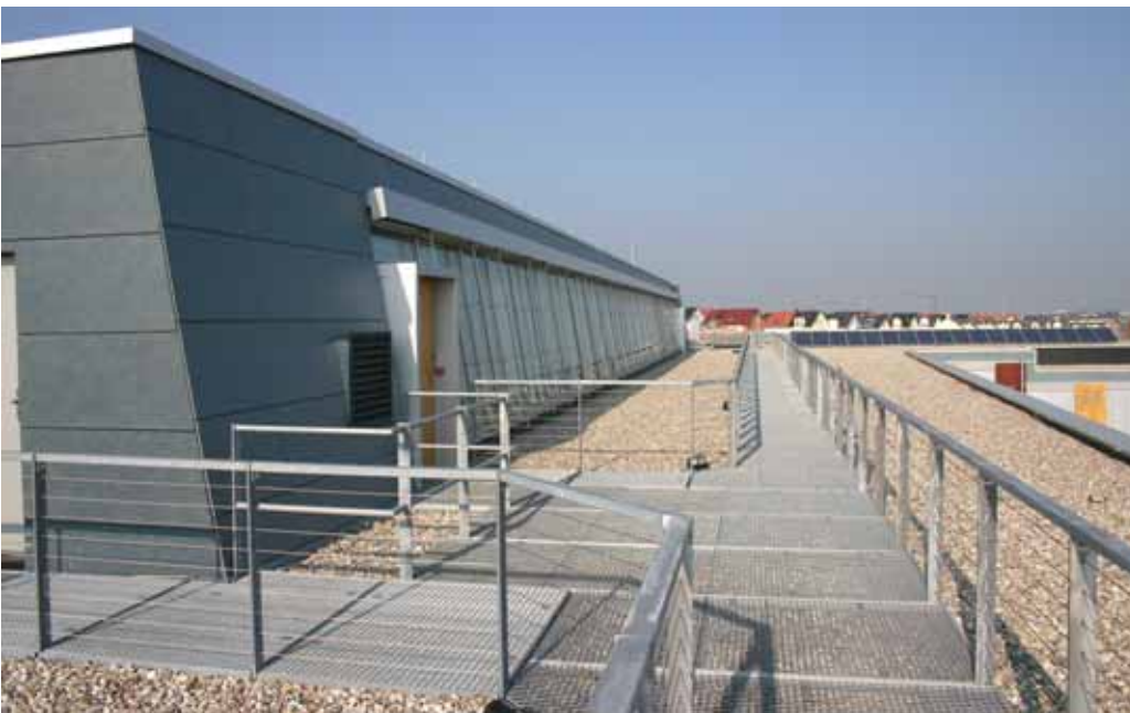
Abbildung 13: Außenansicht der Ostfassade vom 2. OG
