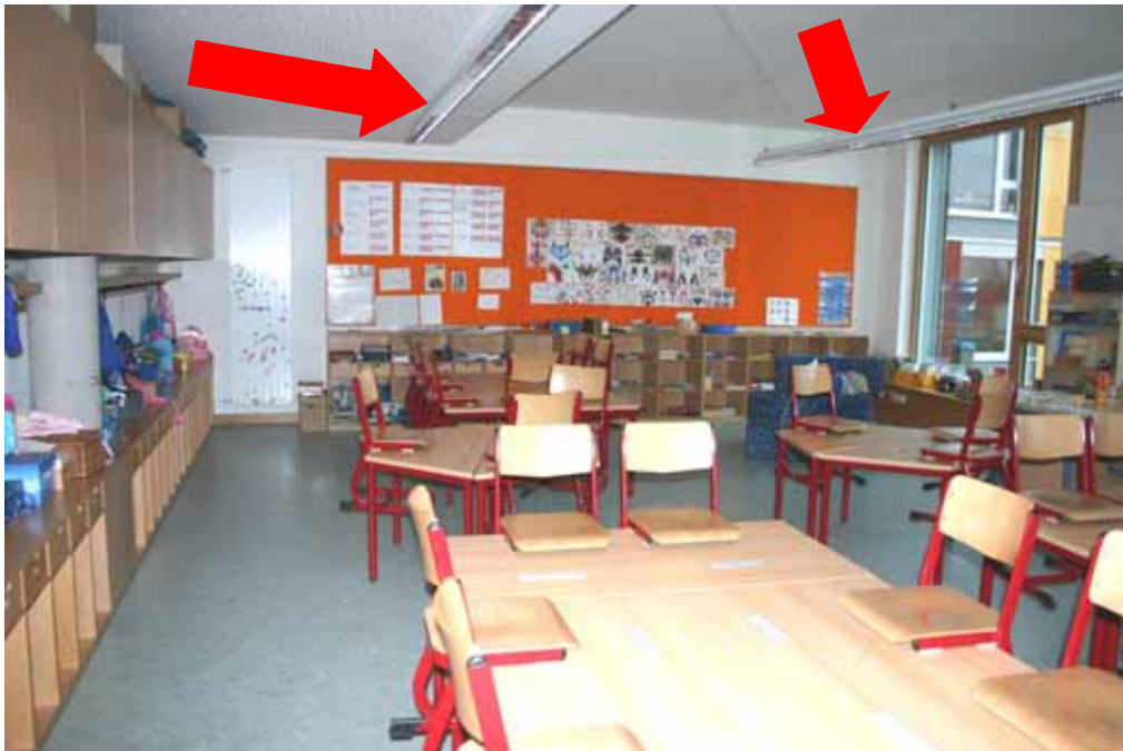
Abbildung 79: Typischer Klassenraum in der Riedbergschule mit zwei Lichtbänder über den Tischgruppen parallel zur Außenfassade.
