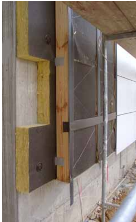
Abbildung 18: Aufbau der vorgehängten Fassade mit zweilagigem Dämmstoff.
