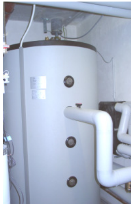
Abbildung 18: Links: Gaskessel für die Heizungs- und Warmwasserversorgung des gesamten Gebäudes. Unten rechts im Bild befindet sich der temperaturkompensierte Gaszähler mit Impulsmessung. Rechts: 1000 Liter Pufferspeicher im Technikraum (Fa. Paradigma, Typ „PS 1000“)
