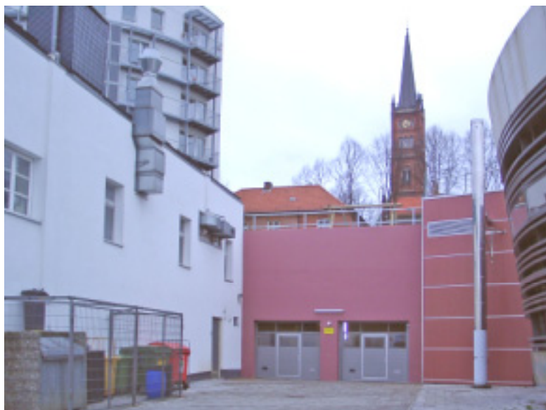
Abbildung 10: Einfahrtstore zu den beiden Tiefgeschossen mit der Quartiersgarage (Zufahrt von der Hafenstraße). Oben links ist ein Teil der Süd-Ost Fassade des Hauses zu erkennen.
