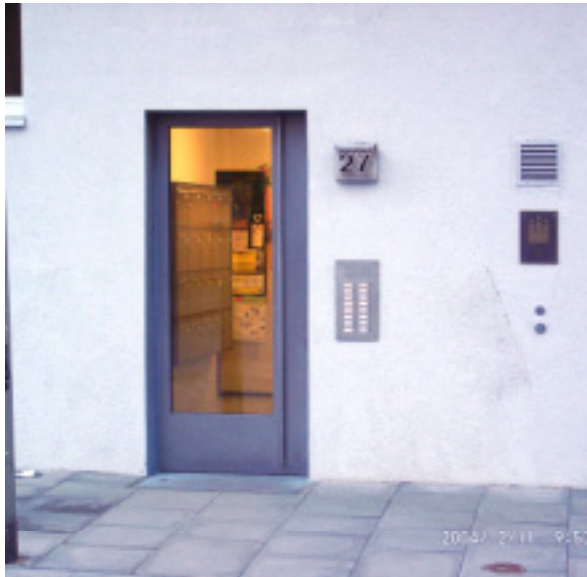
Abbildung 11: Gebäudehaustür auf der Nordseite EG mit der Müllraumbelüftung (Gitter rechts der Hausnummer) und Detail der Balkone an der Nordfassade.
