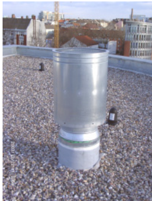
Abbildung 23: Außenluft-Ansauggitter auf der Südwand des Technikraumes von der Dachterrasse gesehen und Fortluftauslass-Haube der zentralen Lüftungsanlage auf dem Dach.
