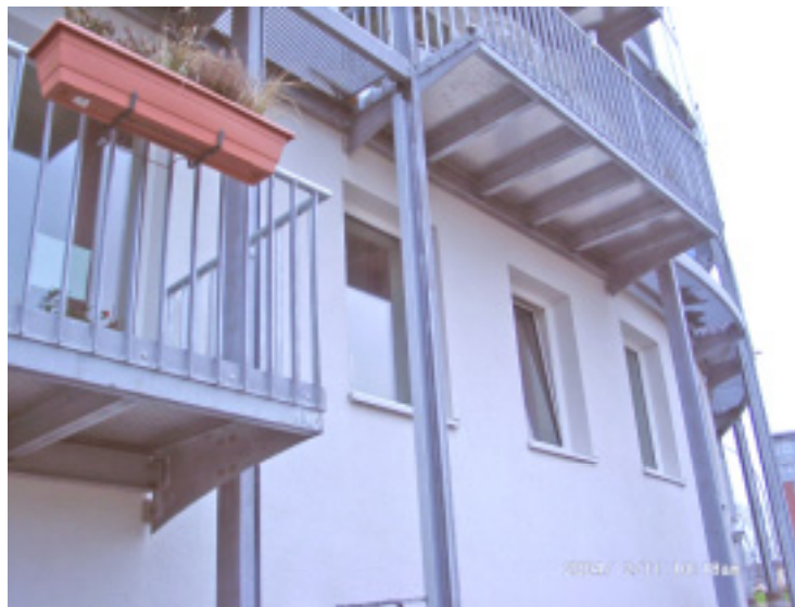
Abbildung 12: Detail der Balkonanlage auf der Südfassade (KG/EG)
