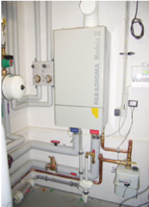
Abbildung 18: Links: Gaskessel für die Heizungs- und Warmwasserversorgung des gesamten Gebäudes. Unten rechts im Bild befindet sich der temperaturkompensierte Gaszähler mit Impulsmessung. Rechts: 1000 Liter Pufferspeicher im Technikraum (Fa. Paradigma, Typ „PS 1000“)
