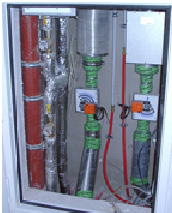
Abbildung 19: Links: Geöffneter Versorgungsschacht im Treppenhaus mit dem Volumenstromregler der Lüftung und dem Nachheizregister einer Wohnung sowie Wasserleitungen. Rechts: Oberster Teil des Fahrstuhlschachtes im DG mit der Verglasung zum Treppenhausbereich und der Rauchabzugsklappe in der Nordfassade.
