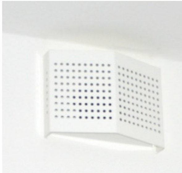
Abbildung 25: Zuluft einlass in einem Wohnraum.
