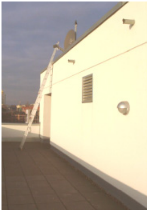
Abbildung 23: Außenluft-Ansauggitter auf der Südwand des Technikraumes von der Dachterrasse gesehen und Fortluftauslass-Haube der zentralen Lüftungsanlage auf dem Dach.
