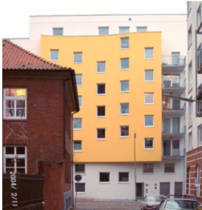
Abbildung 9: Nordansicht des Gebäudes mit der Haustür sowie der Müll- und Fahrradraumtür im EG.
