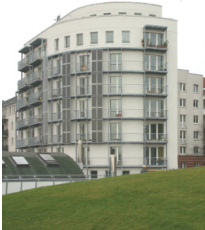
Abbildung 6: Süd-Ost-Ansicht des Gebäudes.
