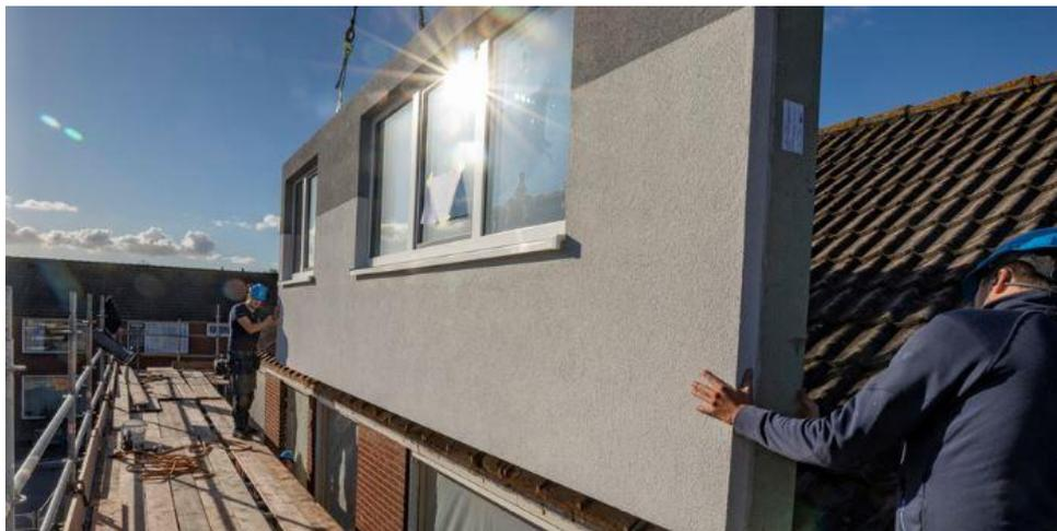
Serielle Sanierung von 194 Reihenhäusern in der Provinz Zeeland, Niederlande, mit vorgefertigten Elementen. Das spart Bauzeit und Baukosten.
