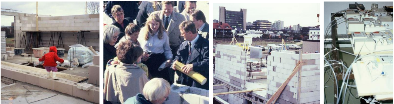
Vom experimentellen Projekt zur Selbstverständlichkeit: Im Herbst 1990 begannen in Darmstadt die Bauarbeiten für das weltweit erste Passivhaus (Bilder 1 und 3). Die Grundsteinlegung fand unter großem öffentlichen Interesse statt (Bild 2). Seit dem ersten Tag wird an dem Gebäude umfangreich wissenschaftlich geforscht (Bild 4). © Privat
