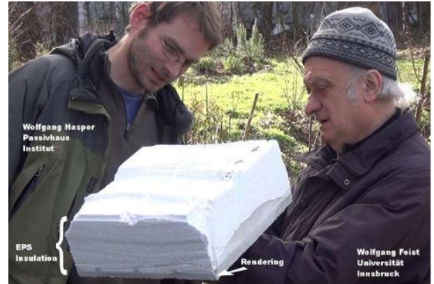
Einwandfreier Zustand: Prof. Wolfgang Feist (r.) untersucht mit einem Kollegen die Dämmung des ersten Passivhauses. Das Stück haben sie zum 25jährigen Bestehen des Gebäudes aus der Hauswand herausgetrennt. © Passivhaus Institut
