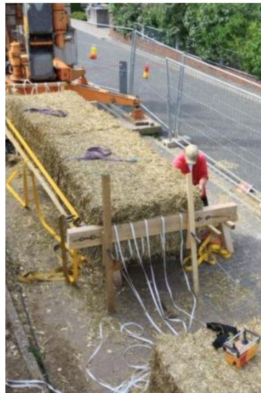
Strohballentisch für die Produktion der Dämmung.
