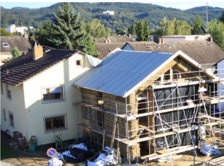
Fertig! Die Dämmung ist drin. Die Ballen sind aufgestapelt, jeweils nach einer Lage Stroh ist eine Art Leiter aus Holz eingelegt.
