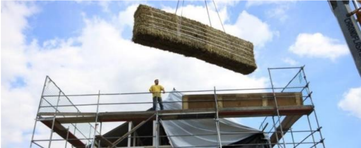
Ein Kran musste her, um die rund 300 Kilogramm schweren Strohballen zu bewegen und als Dämmung an das Haus von Benjamin Krick anzubringen. Das Stroh selbst kommt direkt vom Acker nebenan.
