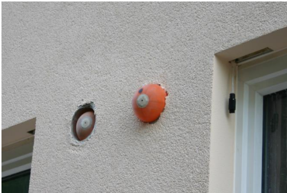
Temporäres Verschließen der Außenluft- und Fortluftöffnung der Lüftungsanlage während des Drucktests
